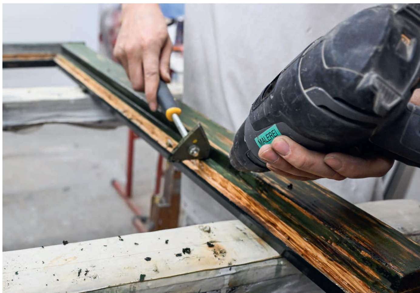
Entfernen der alten Beschichtung durch Erhitzen und Abkratzen.
