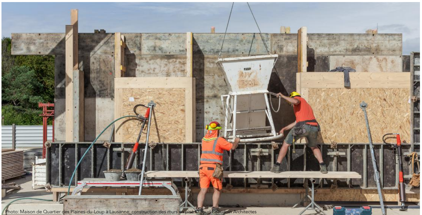
Photo: Maison de Quartier des Plaines-du-Loup à Lausanne: construction des murs en pisé © Joud Beaudouin Architectes
