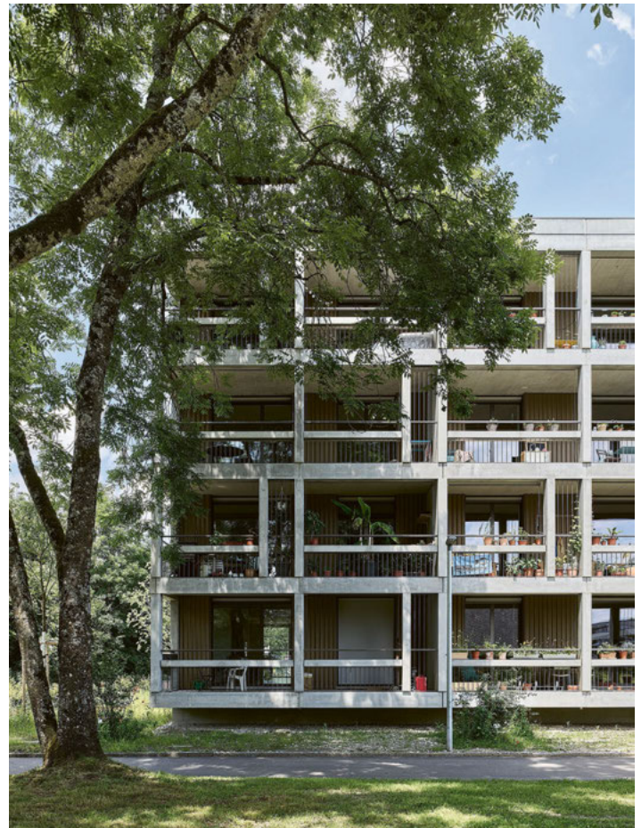
Die Gebäude orientieren sich durch die rechtwinklige Anordnung und Höhenstufung an den Gebäuden des benachbarten Wohnheims Rossfeld.
