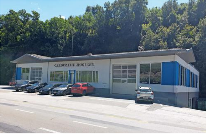
Die Nordansicht der Carrosserie Moderne am Ortseingang von Sitten.
