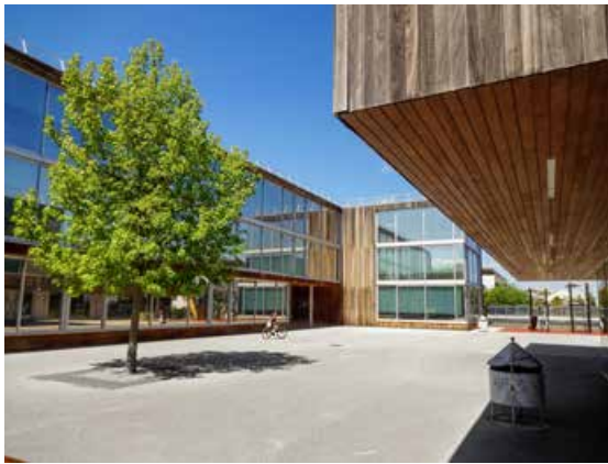
Beim Bahnhof Satigny.
