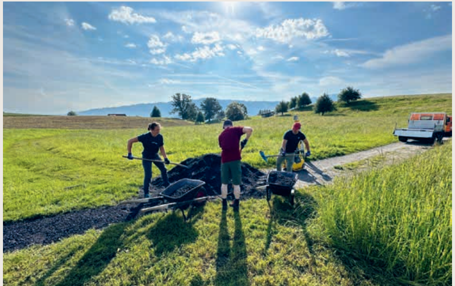
Mitarbeitende der Mobiliar sanieren einen Wanderweg in Risch-Rotkreuz.
