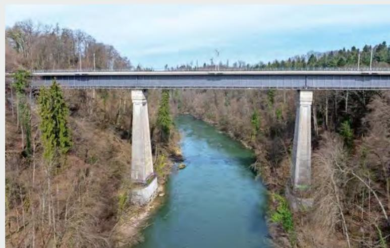
Die Reussbrücke Mellingen von 1877: Hier wurde der Korrosionsschutz mit einem nach Blatt 87 zugelassenen Beschichtungssystem von Sherwin-Williams erneuert.
