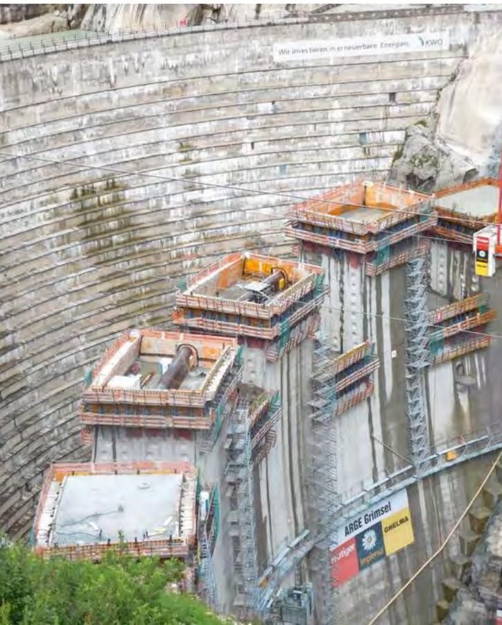
Die Mauer ist in Blocksäulen als Vorläufer ohne Bewehrung, gefolgt von den dazwischenliegenden Nachläufern, betoniert worden. Vom gesamten Betonvolumen von 224 000 m<sup>3</sup> entfallen rund 80 000 m<sup>3</sup> auf Mass beton, 120 000 m<sup>3</sup> auf Vorsatzbeton und 15 000 m<sup>3</sup> auf Kontaktbeton.
