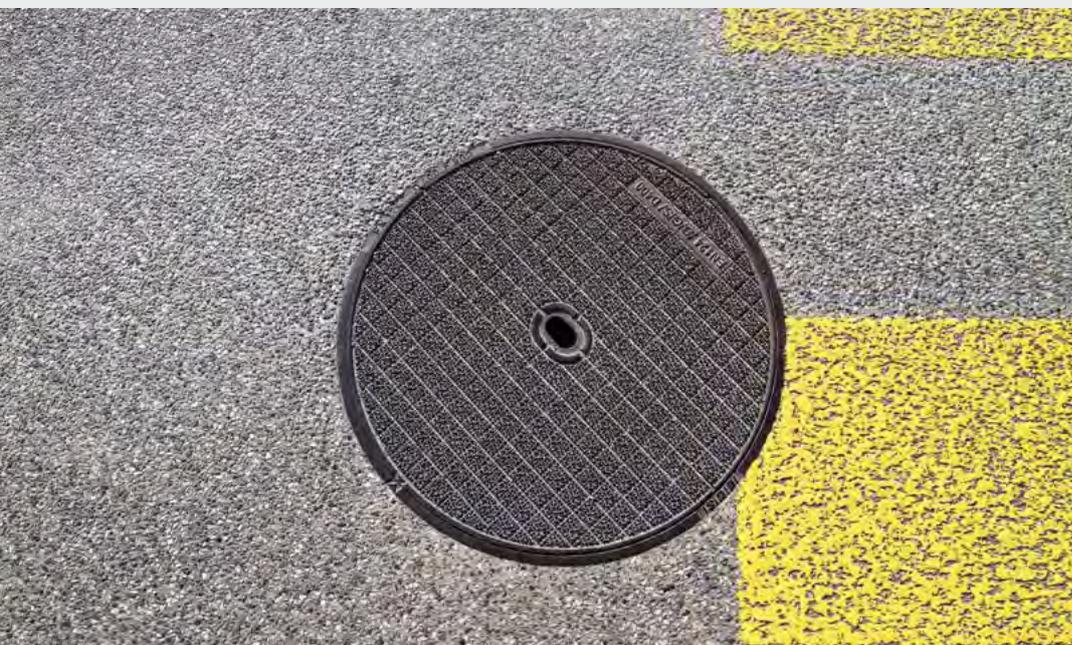
Durch den Einsatz der Abdeckungen BGS Grip kann der Lärm deutlich reduziert werden.
