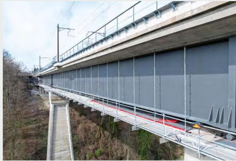
Die modernen Korrosionsbeschichtungssysteme von Sherwin-Williams erlauben im Winter eine reduzierte Beheizung der Einhausung und sparen damit Energiekosten.
