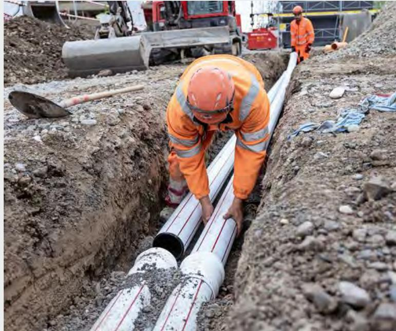
Auch die Werkleitungen werden erneuert. Die Debrunner Acifer AG ist unter anderem mit Sicker- und Kabelschutzrohren an der Bahnhof-Gesamterneuerung beteiligt.
