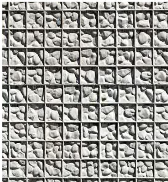
Im Saint-Jean-de-Maurienne-Tal verwendeten die Verantwortlichen zwei verschiedene Schalungsmatrizen. Eine wurde speziell für das Projekt entwickelt und bildet die Oberflächenbeschaffenheit von Gabionen wieder. Um die Struktur Gabion zu entwickeln, beauftragte Noe eigens einen Künstler.
