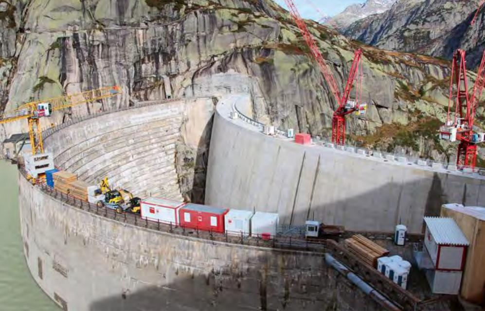
Vor der mehr als 90 Jahre alten stufenförmig abgetreppten Staumauer Spitalamm des Pumpspeicher-Kraftwerks Grimsel ist in vier Sommer-Bausaisons eine neue Sperre betoniert worden. Diese weist eine Höhe von 113 m und eine Kronenlänge von 212 m auf.
