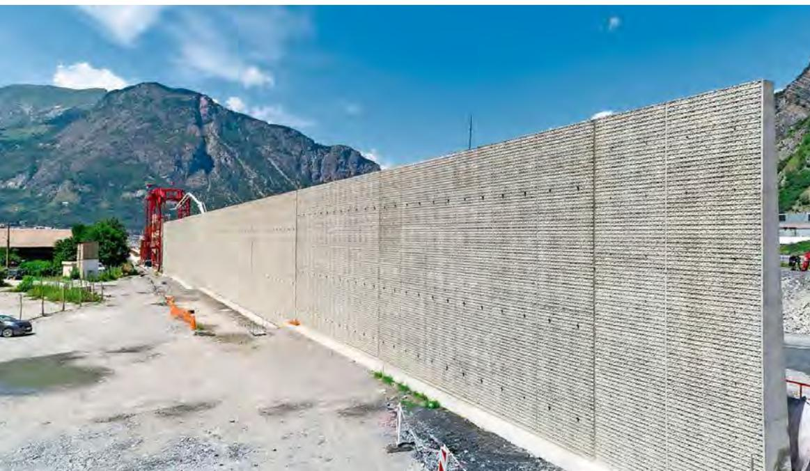
Architekten und Auftraggeber entschieden sich für Betonwände, deren Oberfläche die Struktur von Gabionen nachbilden.
