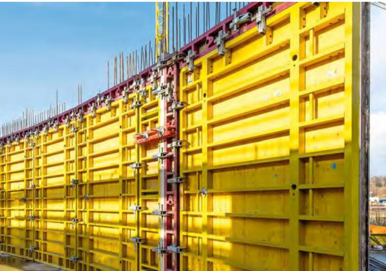
Mittels aufgedoppelter Knaggenkästen auf den Maximo Struktur Wandschalungselementen liessen sich runde Wände massgenau, in sehenswerter Sichtbetonqualität errichten.
