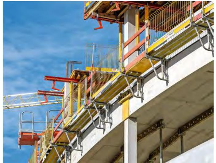
Sonder-Deckentische auf Basis der Variodeck Stahlriegel-Deckentische dienen gleichermaßen als Arbeitsbühne und Auflagerkonstruktion für die runden Fertigteilbrüstungen.
