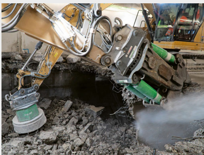
Trennung der verschiedenen Baustoffe während den Rückbauarbeiten.
