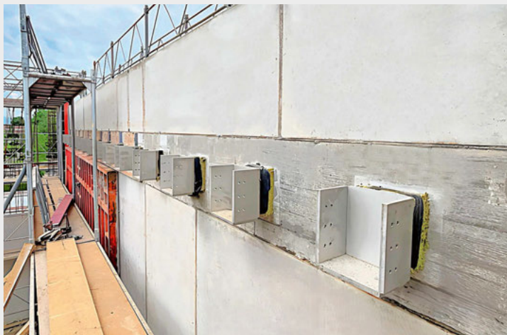
Gefertigtes Sonderelement vor der Lieferung (Bild links) und als einbetonierte Elemente vor dem Einbau der Holzbausträger.
