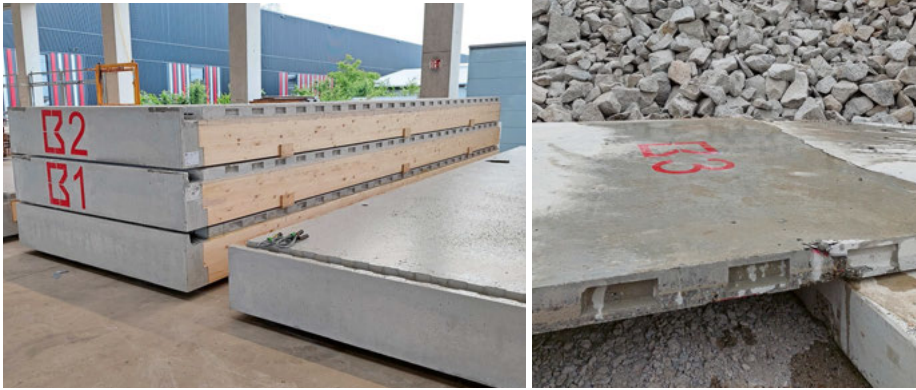
Die rückbaufähigen Elemente können nun bei einem neuen Objekt zum Einsatz kommen (Bild links). Die Trennung von Holz und Beton ermöglicht das sortenreine Recycling. Die Betonplatte wird zu RC-Gesteinskörnung Typ I aufbereitet (Bild rechts).
