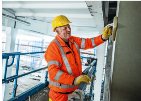
500 m 2 Binderflächen wurden zunächst vorbereitet und anschliessend mit einem Oberflächenschutzanstrich versehen. Zur Finalisierung der Oberflächen wurde der Auftrag per Hand verrieben.
