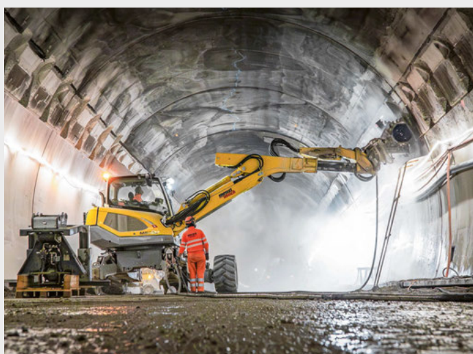
Präziser Einsatz der Universalfräse im Gubristtunnel.
