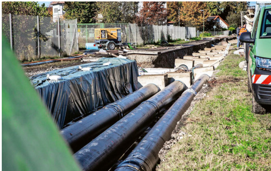
Die Leitungen des Fernwärmenetzes Memmingen werden mit Flüssigboden verfüllt.
