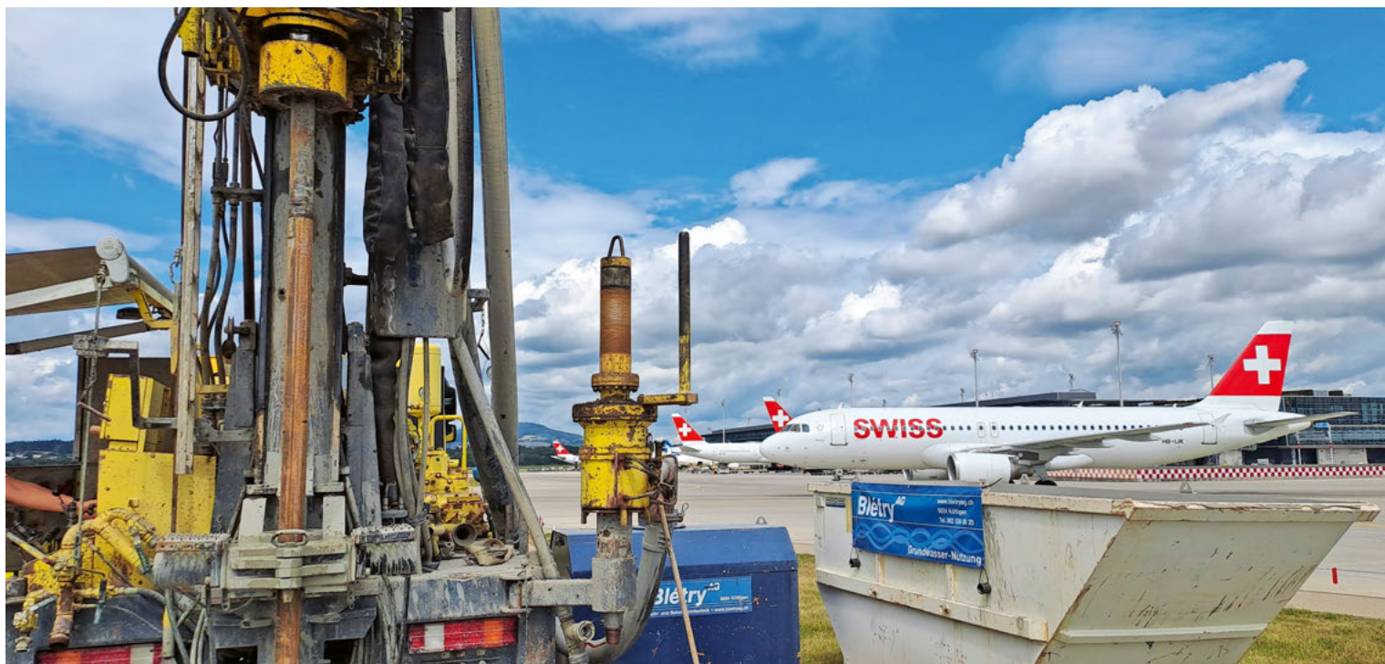
Die Sondierbohrungen brachten wichtige Erkenntnisse zur Beschaffenheit der Rinne.
