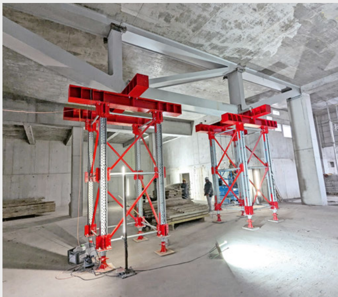
Unterstützung eines Fachwerks mit Betondecke. (Bild: Meva)
