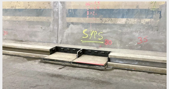
Einbau der Schlitzrinne und des Syphonschachtes.
