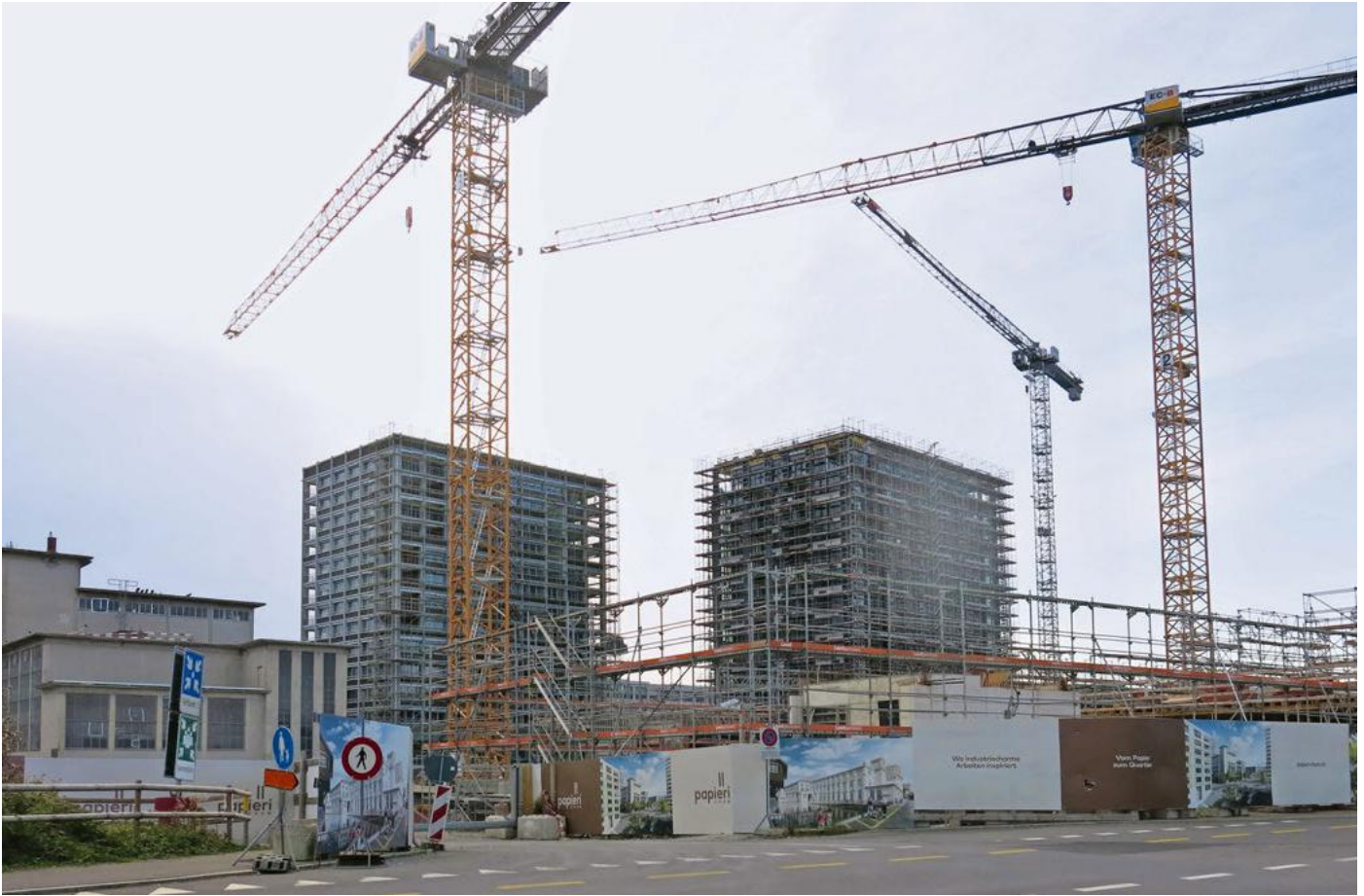
Im Rahmen der zweiten Baustappe werden zwei Wohnhochhäuser erstellt.
