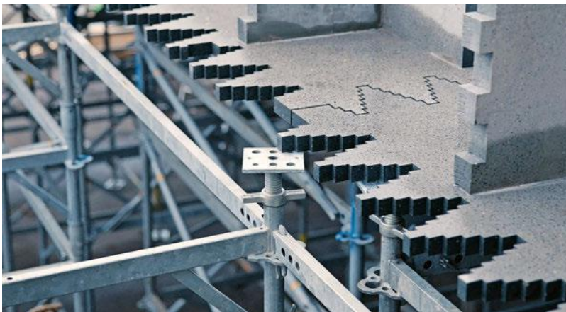
Die transportfähigen Bauteile können auf der Baustelle mittels kraftschlüssiger Verbindungen zu Grossbauteilen zusammengefügt werden. (Foto: Holcim)
