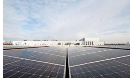
Nebst der Solaranlage auf dem Dach beherbergt das Parkhaus ausserdem einen neuartigen Erdwärmespeicher. (Foto: SAM Architekten/Fabio Compagno)
