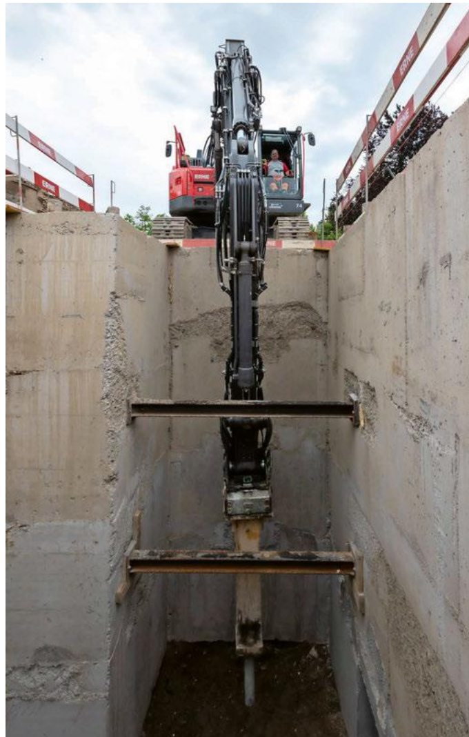
Zwei Stapelbecken und Notausstiege werden neu-, die zwei bestehenden Notausstiege und die Tunnelzentrale umgebaut.
