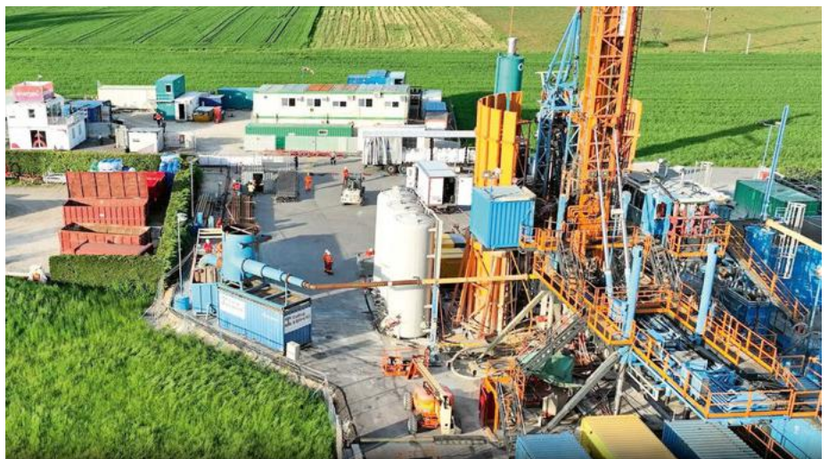
In Vinzel zeigte die erste Bohrung in mittlerer Tiefe die Existenz einer sprudelnden geothermischen Ressource mit einem Ausstoss von 150 l/s und einer Temperatur von 33 °C.
