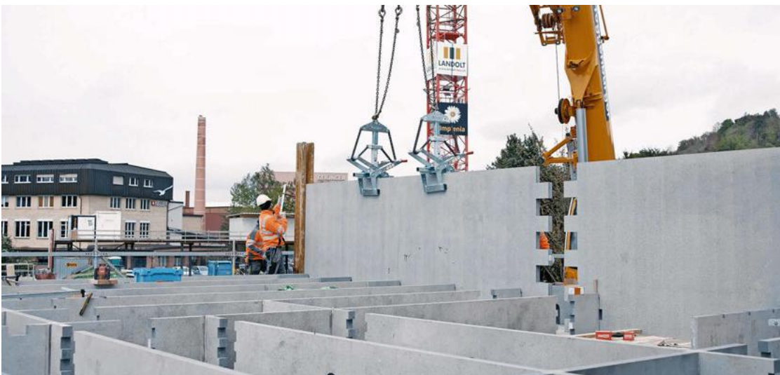
Die CPC-Betonplatten werden im Werk gefertigt und auf der Baustelle zusammengesetzt. (Foto: Holcim)
