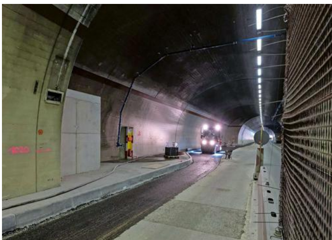
Das Projekt umfasst die Erneuerung der Bankette mit Kabelrohranlage und Löschwasserleitungen sowie der Tunnelbeschichtung.
