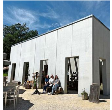
Das aus vorfabrizierten Elementen erstellte Besucherzentrum des «Campus Galli».
