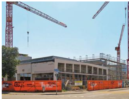
Unter der filigranen Betonstruktur des ehemaligen Ausstellungs- und Montageraums entsteht eine öffentlich zugängliche Stadtloggia.
