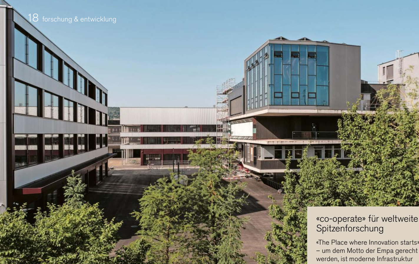
Die neuen Fassaden – links das Labor-, hinten das Multifunktionsgebäude – spiegeln die Dynamik des bestehenden Nest-Gebäudes (rechts) wider. (Foto: Empa)
