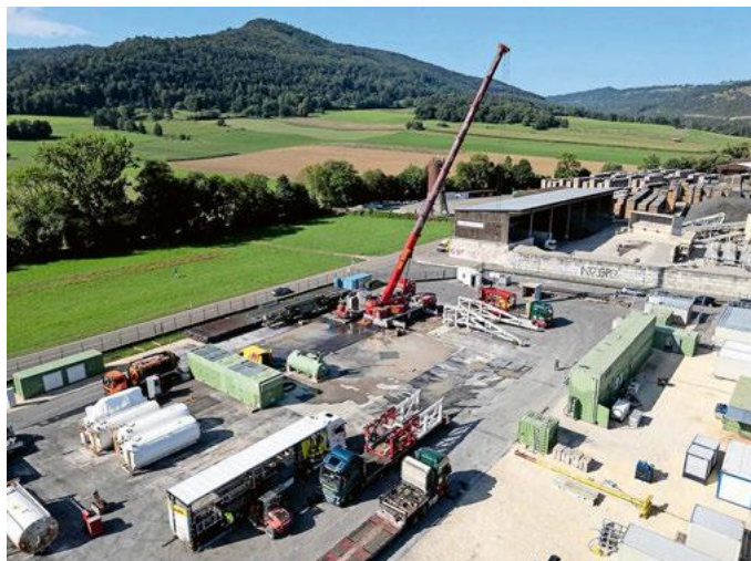
Bei der ersten Geothermie-Bohrung im Rahmen des Pilotprojekts Haute-Sorne (JU) konnte in weniger als drei Monaten 4000 Meter in den Untergrund gebohrt werden.
