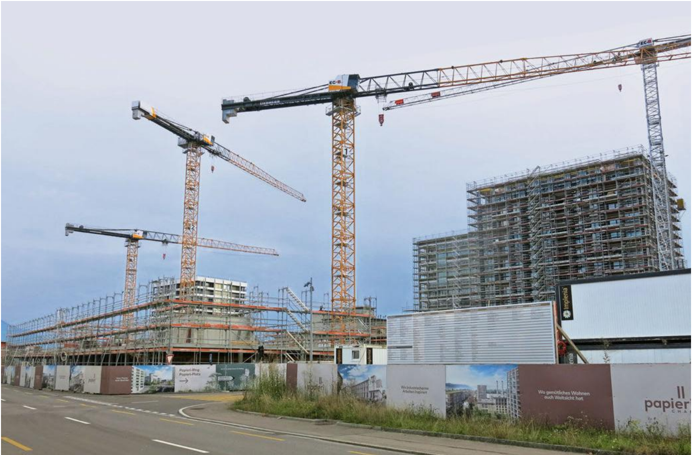
Bis 2026 entstehen an der Knonauerstrasse die Gebäude E und F mit 6500 Quadratmeter Wohn- und 12500 Quadratmeter Gewerbefläche.
