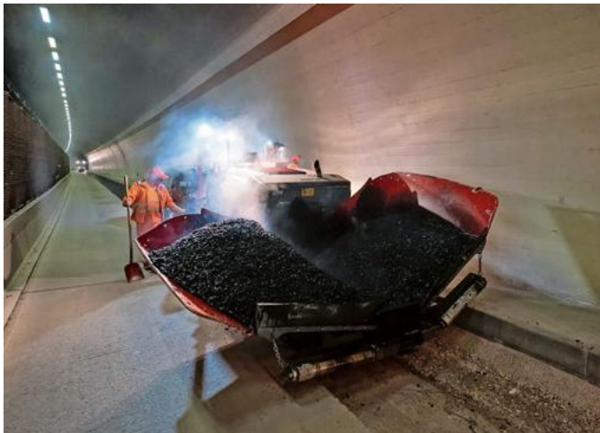
Enge Platzverhältnisse: Im Bankettbereich liegt die Arbeitshöhe bei 4,50 und die Breite der Arbeitsfläche bei drei Meter.
