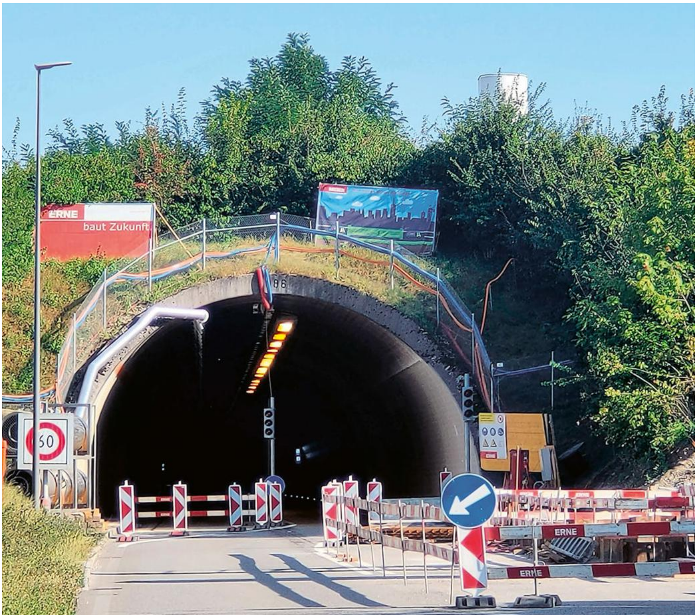
Der Tunnel der Nordumfahrung Bad Zurzach wird bis Herbst 2025 bei laufendem Verkehr saniert. (Foto: Werner Aebi)
