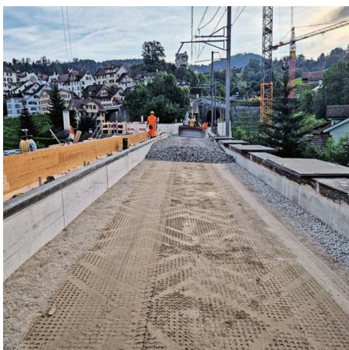
Die Südostbahn erneuert das Bahntrasse zwischen Herisau und Lichtensteig. Im Bild der Abschnitt bei Lichtensteig.
