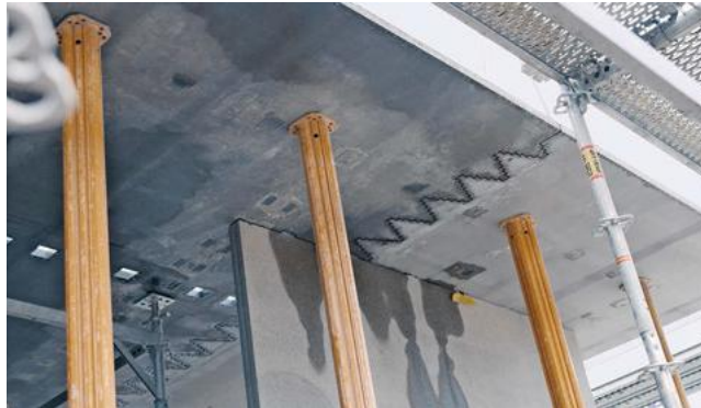
Deckenschalungen sind nicht mehr notwendig. (Foto: Holcim)
