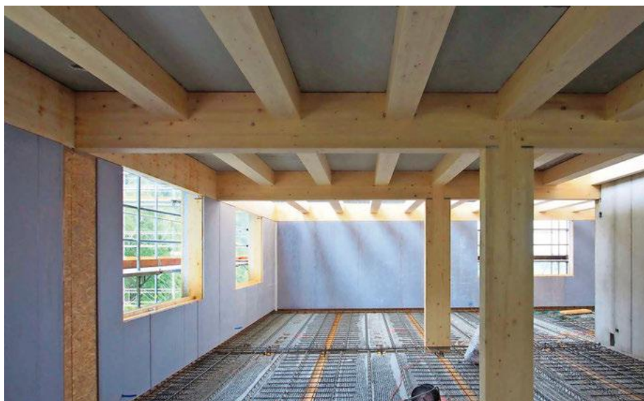
Untersicht der Holz-Beton-Verbunddecken.
