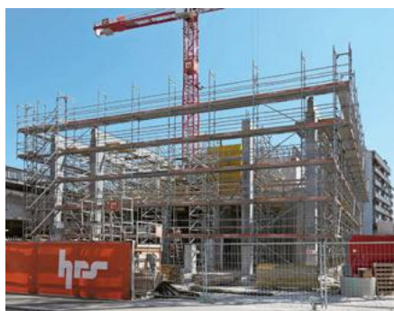
Auf dieser Betonstruktur fusst das geplante, 25 Stockwerke hohe Wohn-Hochhaus.
