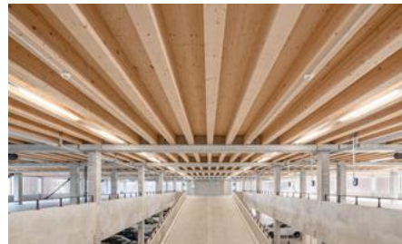
Die Holzdecke des Parkhauses. (Foto: SAM Architekten/Fabio Compagno)
