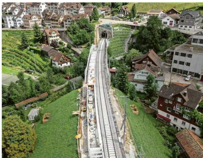
Der gereinigte Gleisschotter ist kaum von neuem Material zu unterscheiden.
