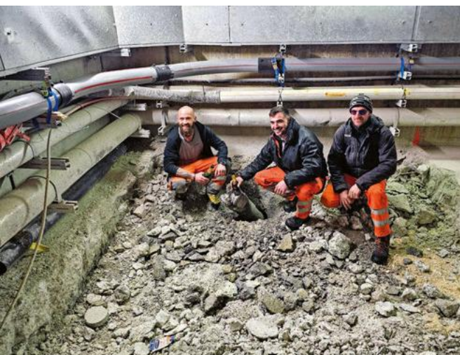
Im März 2024 erfolgte der zielgenaue Durchstich der 765 Meter langen Bohrung.
