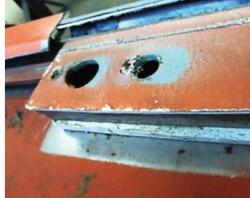
Beim Demontieren von Brandschutztüren lauert Asbestgefahr.
