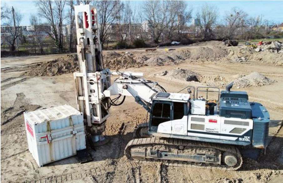
Der HD Hyundai HX 520 AL mit dem Impulsverdichter von Terra-Mix.
