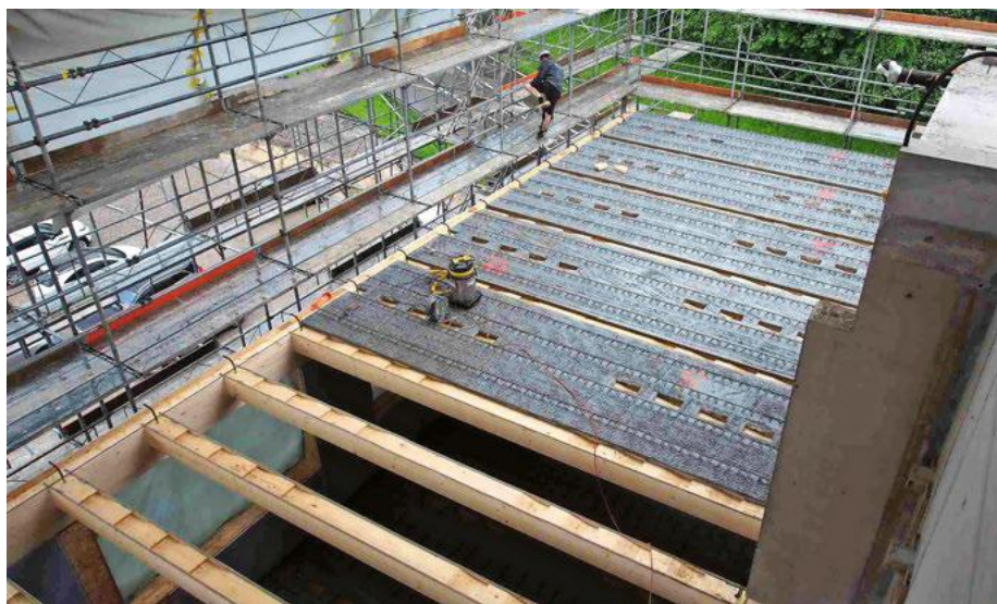
Konstruktion der Holz-Beton-Verbunddecken.
