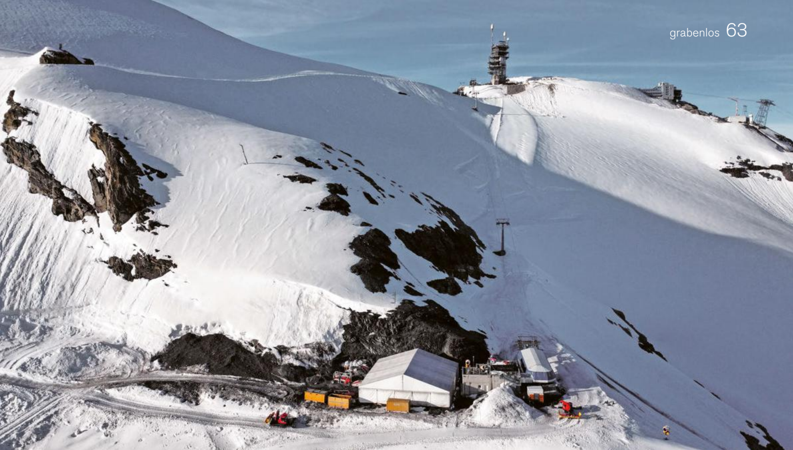
Blick auf den Installationsplatz Rotstöckli unterhalb des Klein Titlis.
