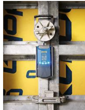
Der Sensor «DokaXact Load» dient zur präzisen Überwachung der Schalungslast in Echtzeit.
