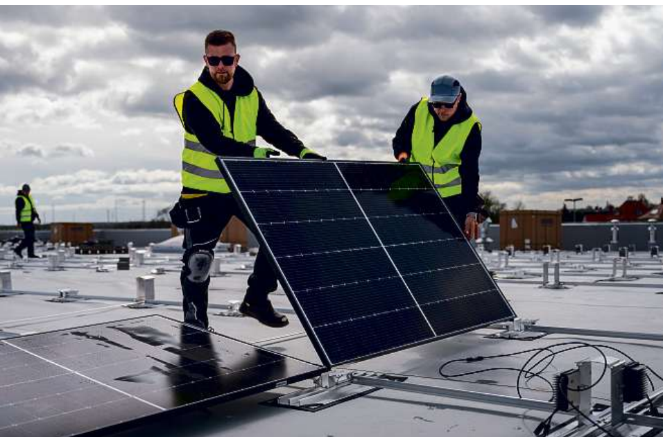
Montagesysteme von Schweizer benötigen durch ihre aerodynamische Konstruktion nur wenig Ballast, zudem werden sie ohne Dachdurchdringung montiert.
