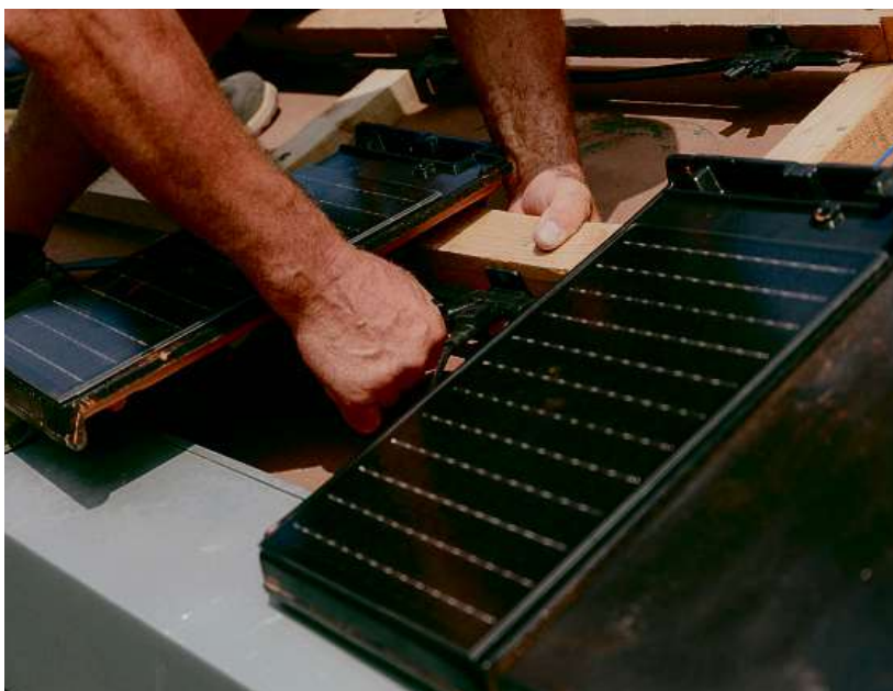
Die Montage der Solardachziegel erfordert keinerlei elektrische Fachkenntnisse. Auch ändern sich weder die Arbeitsprozesse noch die Anforderungen oder Masse.
