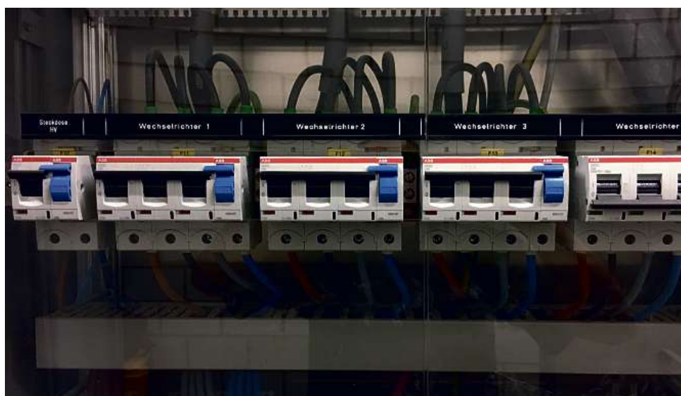
Korrekt verbaute Sicherungselemente.
