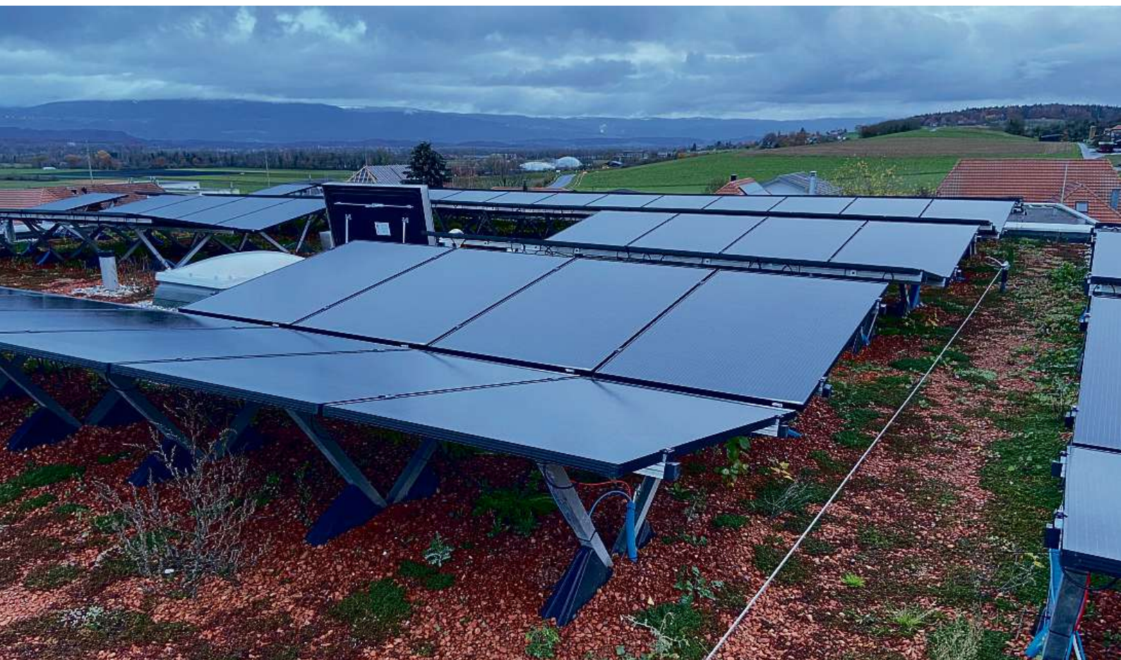
Erhöhte Unterkonstruktion – guter Zugang für Unterhaltsarbeiten.
