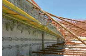
V-Max Board WD®: Verwendung bei innenliegenden Fugenbändern
