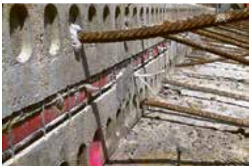
V-Max Board IT®: Verwendung bei Abdichtungen mittels Injektionssystemen
