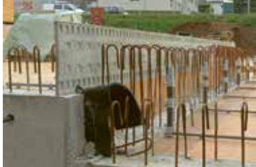
V-Max Board®: Verwendung in Bodenplatten und Decken
