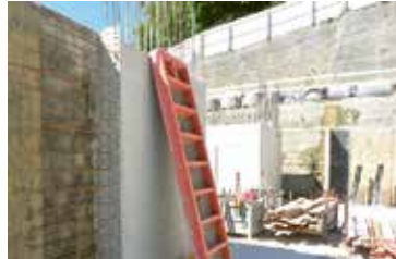
V-Max Board®: Verwendung in Wänden = weniger Etappen → mehrere Etappen können gleichzeitig betoniert werden
