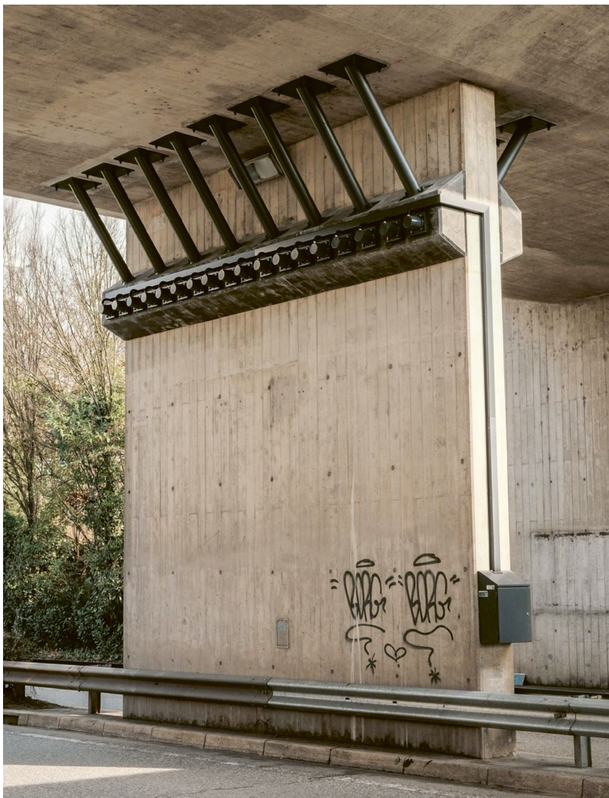
1 Structurame, ponte ferroviario di Près-Bois, Vernier, 2023-2024
