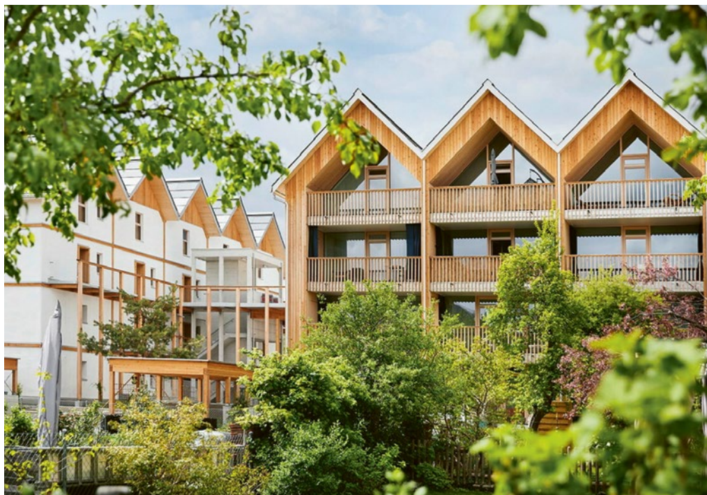
2 Atelier Schmidt, edificio residenziale a 3 piani con struttura portante in balle di paglia a Nänikon. Foto Beat Brechbühl
