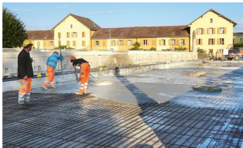
4-5 Ponte Guillemaux a Payerne (Louis Bosset, 1921). Conservazione dell'opera mediante il rafforzamento della struttura. Foto Eugen Brühwiler
