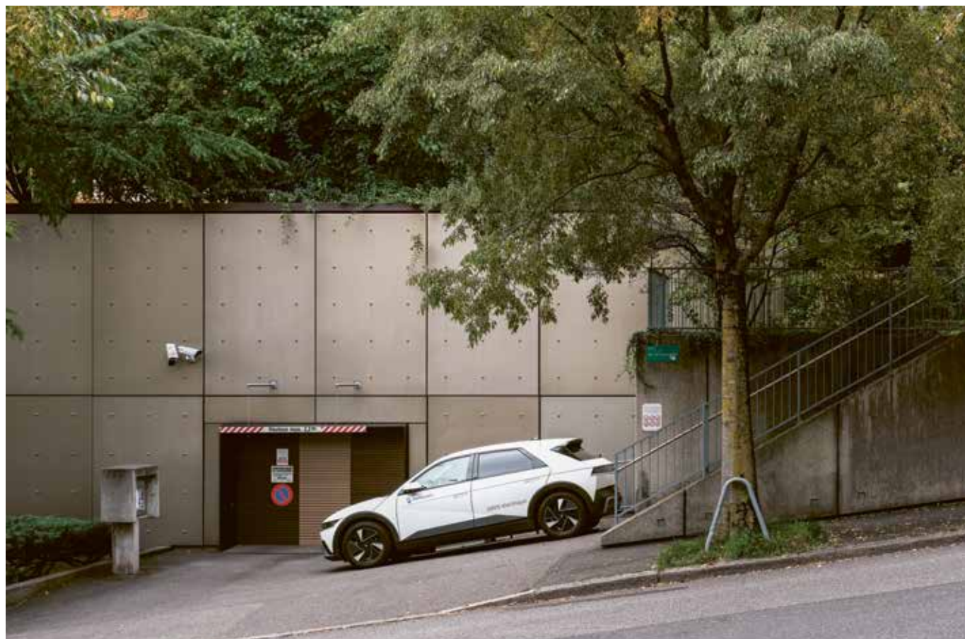
P. 11: Equinix, GV2, Vernier (GE), 2009, reconversion d'un bâtiment industriel construit en 1967
