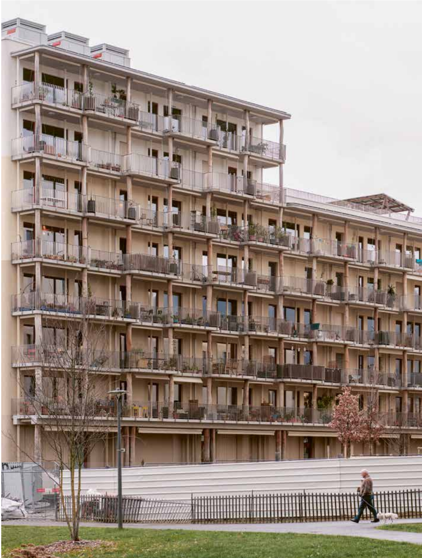
Le D4, dernier data center d'Infomaniak, se niche dans les sous-sols de la coopérative La Bistoquette. (JULIEN HEIL)
