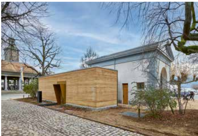
Une extension à la façade en chaux chanvre a été accolée au bâtiment historique. Elle abrite cuisine, sanitaires et accès à un sous-sol technique.
