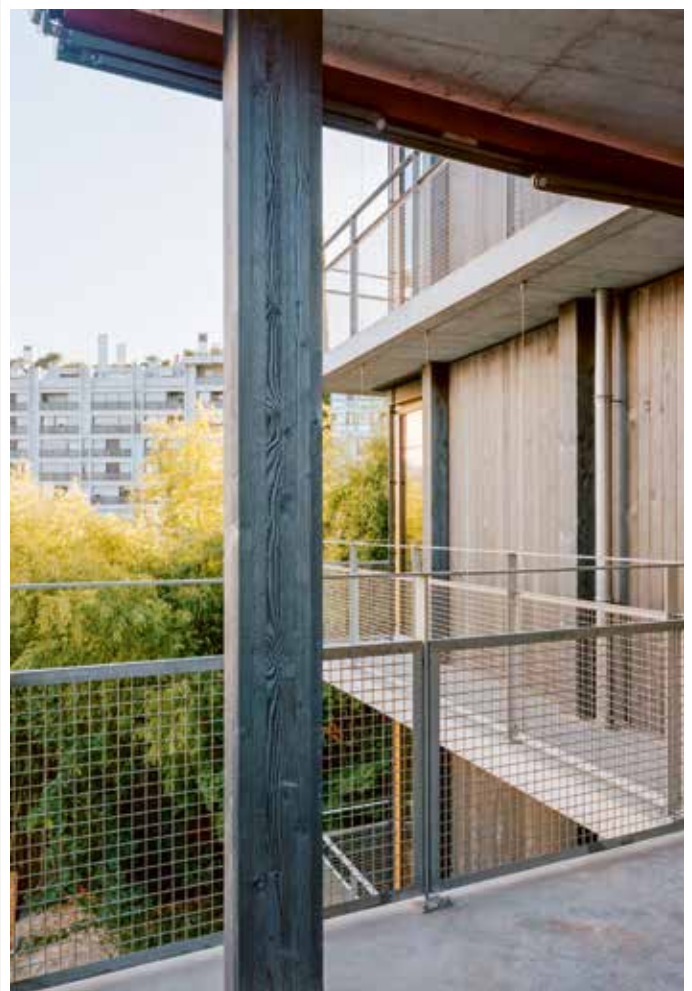
Les coursives, de même que les logements en clusters, sont devenus la marque de fabrique du mouvement coopératif. Ici, les étroits balcons filants s'en inspirent directement. Ils sont continus, mais des volets mobiles permettent de choisir de laisser le passage libre ou, au contraire, de délimiter son chez-soi. (FEDERICO FARINATTI)
