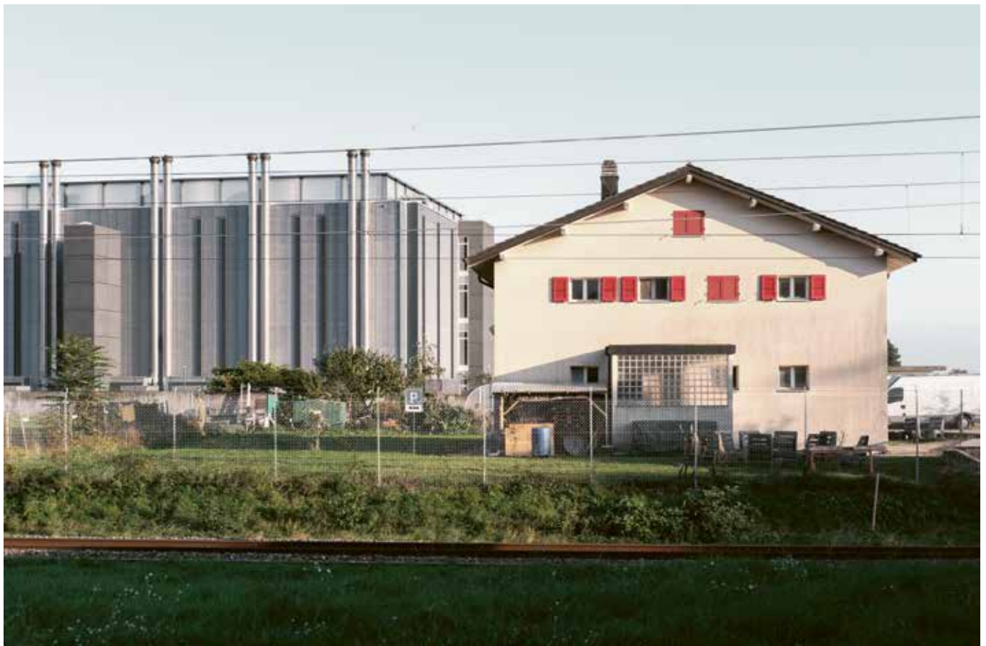
P. 14 : Swisscom Geneva-Montbrillant, Genève, 1983, ancien centre de télécommunications, architectes : Werner et Igor Francesco et Jacques Vicari En haut : Brainserve, Crissier (VD), 2010, architectes : CCHE, entreprise totale En bas : Stack, GEN02, Gland (VD), 2017, 80 000 serveurs, 14 400 m 2 sur une parcelle de 3 ha, le plus gros data center de Suisse aujourd'hui
