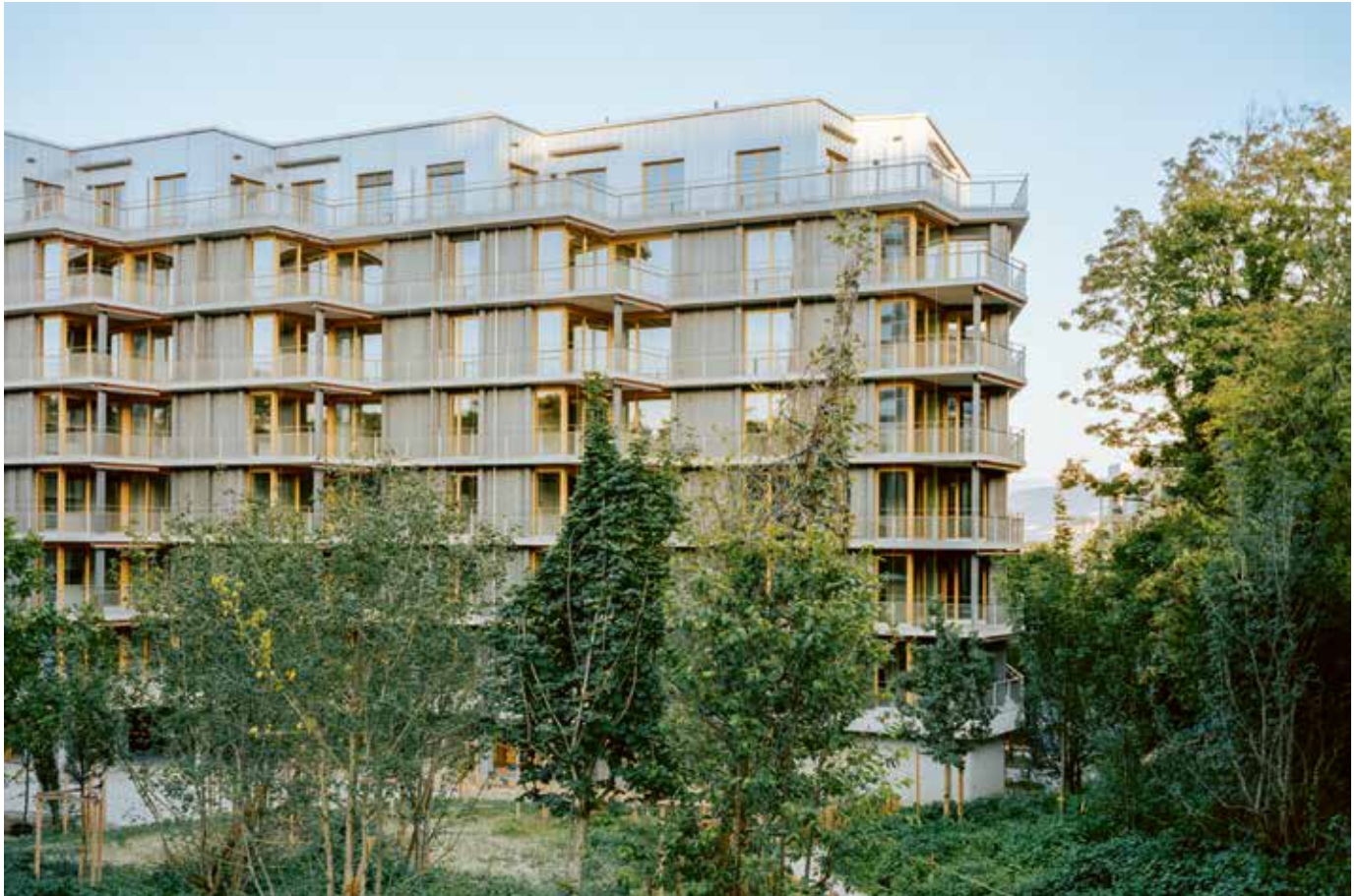
La coopérative de logement Crocodile à Genève. Le jeu plastique et matériel de la barre de logements résulte d'un plan en épi, et donne l'impression que le bâtiment « regarde » vers le sud. (FEDERICO FARINATTI)
