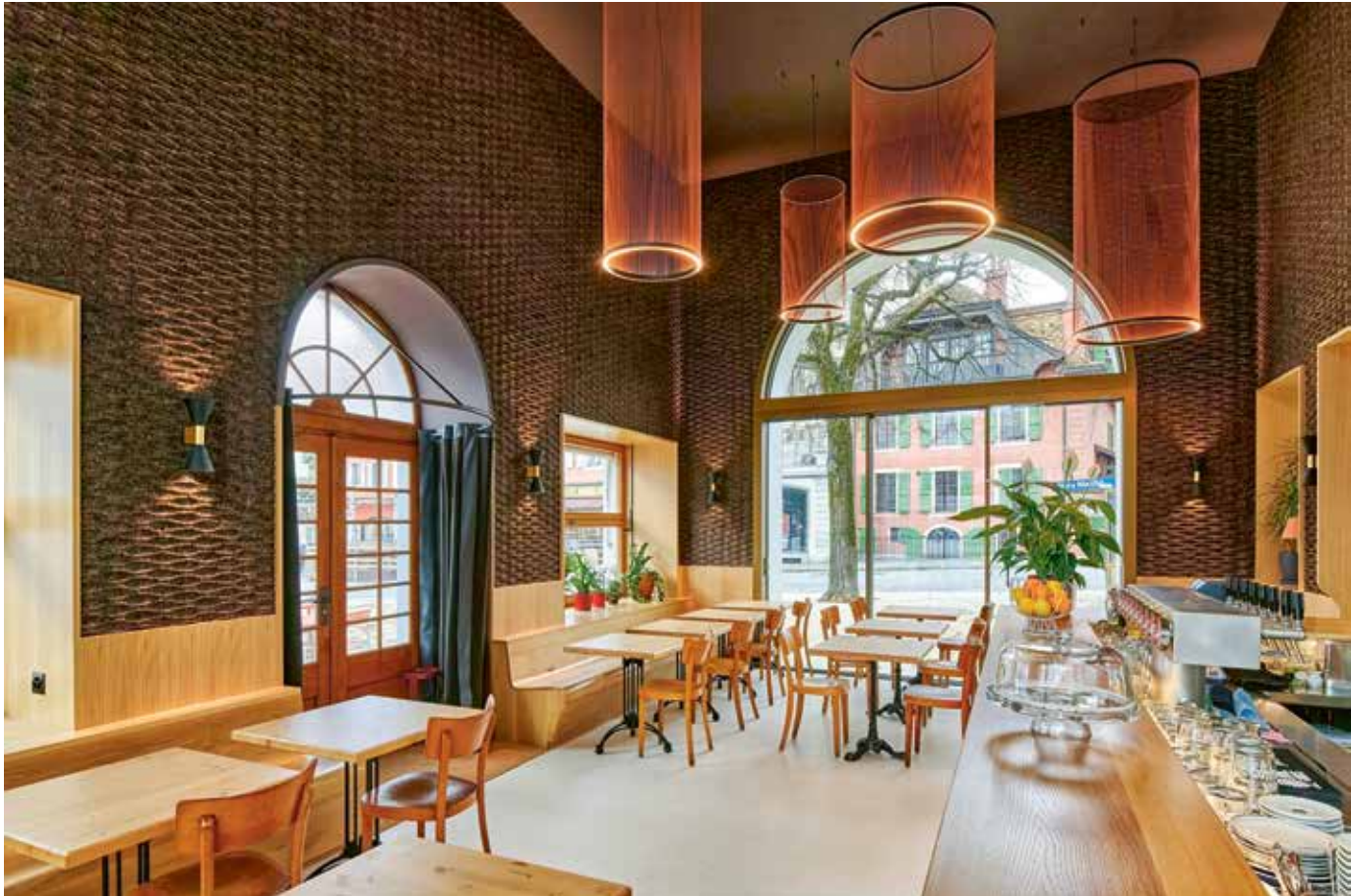
Pour l'intérieur du café, un revêtement en liège doublé d'une couche de laine de chanvre a été utilisé.
