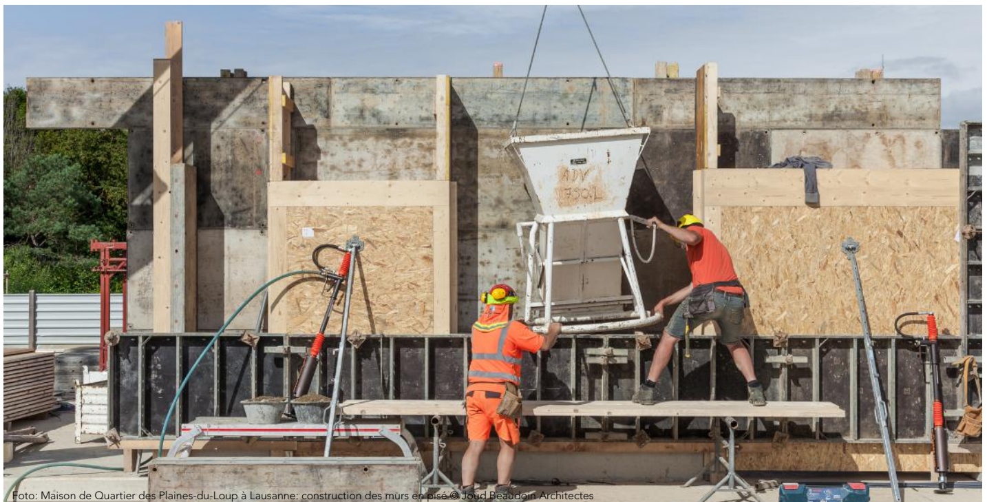
Foto: Maison de Quartier des Plaines-du-Loup à Lausanne: construction des murs en pisé © Jody Beaudoin Architectes
