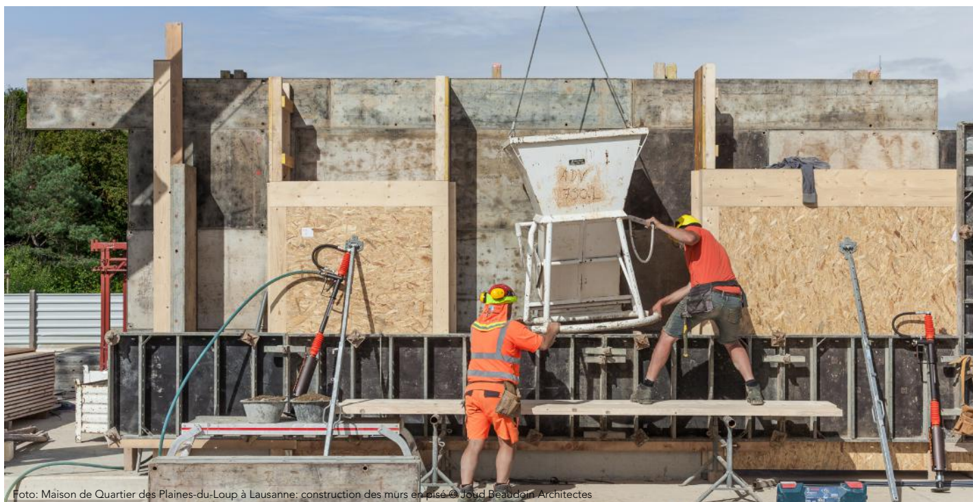
Foto: Maison de Quartier des Plaines-du-Loup à Lausanne: construction des murs en pisé © Jody Beaudoin Architectes
