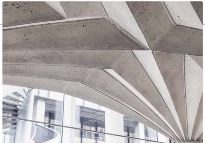
Diese Gewölbedecke aus unbewehrtem Beton entstand mit der neuartigen Schalung «Unfold Form».
