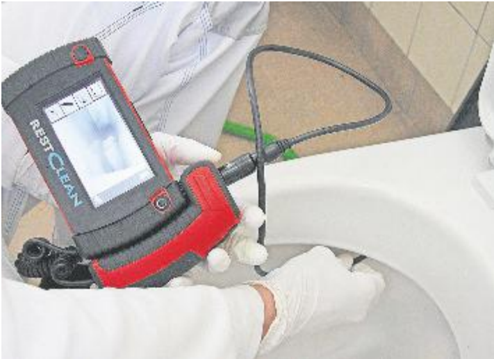
Ablagerungen in den nicht sichtbaren Bereichen der Keramik und des Spülkastens sind die Ursache für Störungen in der Toilettenspülung.
