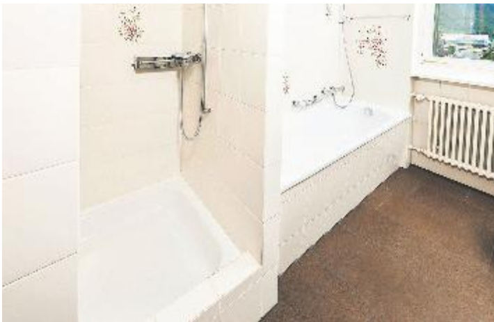
Schon nach einem Tag kann man wieder in die neue Wanne steigen.
