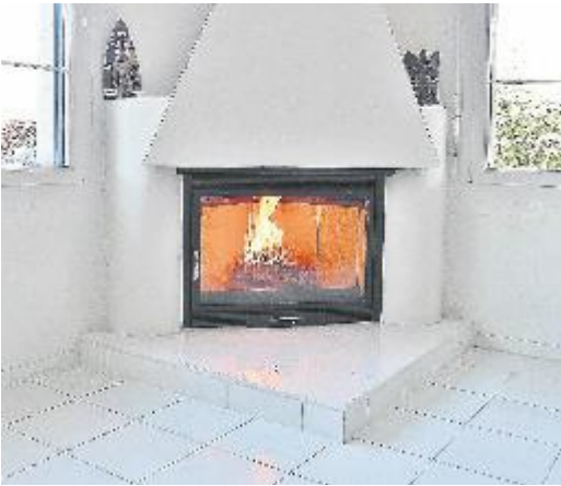
Ein offenes Cheminée hat einen Wirkungsgrad von circa 15 Prozent; mit der leistungsstarken und umweltfreundlichen Hein-Heizkassette erreicht es einen geprüften Wirkungsgrad von 82 Prozent, auch reduziert sich der Feinstaub von 500 mg/m3 auf nur noch 37 mg/m3.
