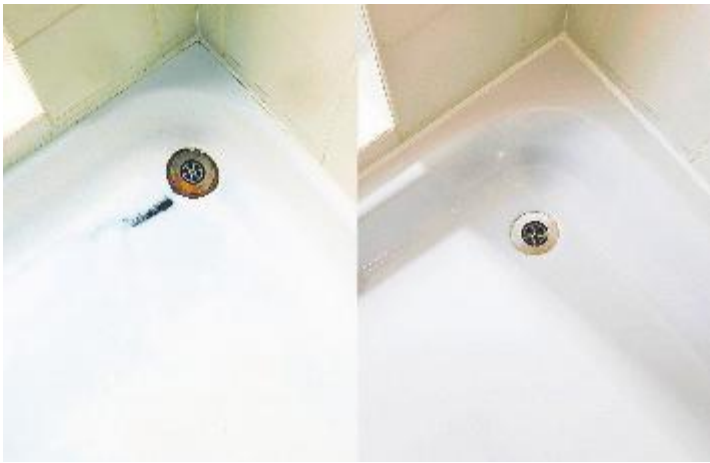
Zerkratze und raue Bade- und Duschwannen können kostengünstig ersetzt werden.
