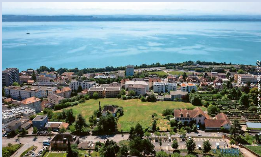
Der Erlös der Emission fließt zum Teil in die Finanzierung des Projekts «Concept B.180», das in Neuchâtel geplant ist (Baugrund s. freies Areal in der Bildmitte).
