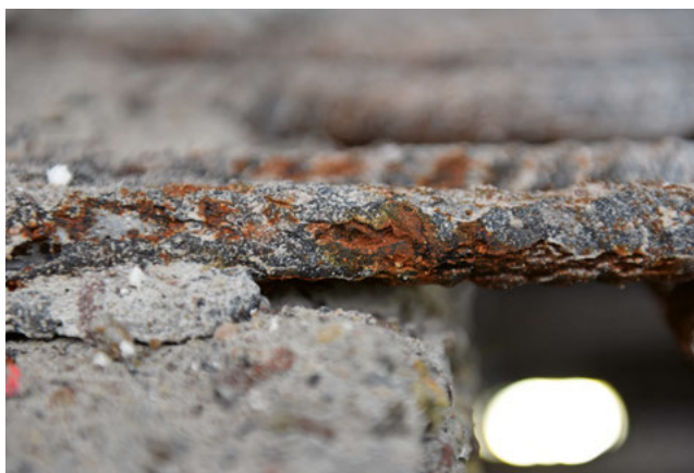
Korrosion aufgrund von Chlorideinwirkung.
