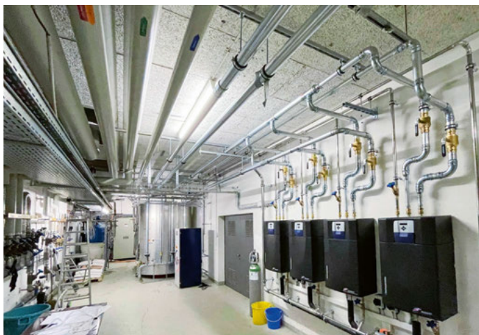
Eine Kaskade aus vier Frischwasserstationen (rechts im Bild) stellt Warmwasser hygienisch und bedarfsgerecht bereit. Die Geräte sorgen zugleich für die passende Temperatur im 900 m langen Kreislauf. (Bild: Grünig&Partner AG)
