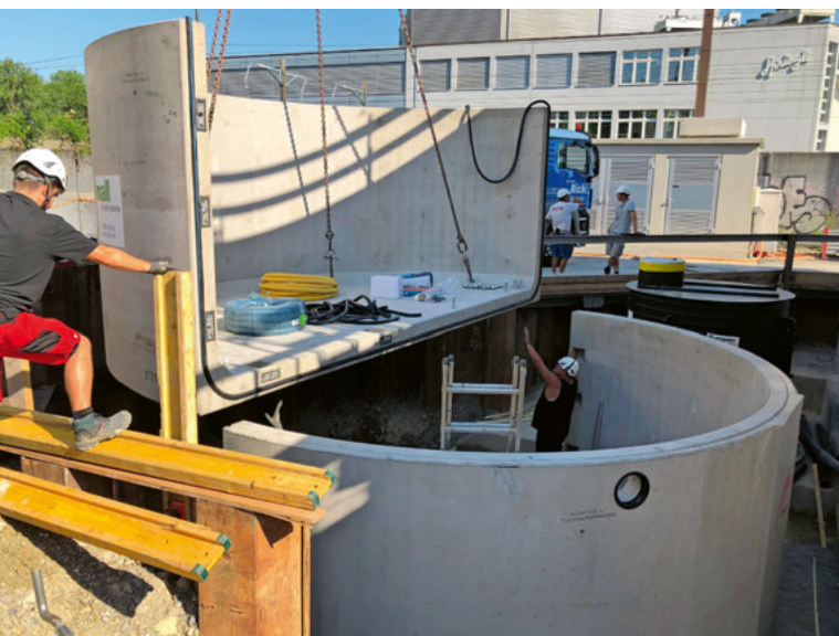
Die vorgefertigten Betonteile der zwei Pelletspeicher für die Siedlung «Reitmen» liessen sich innert weniger Stunden verbauen. Später wurden darüber Parkplätze realisiert. (Foto: Mall AG)
