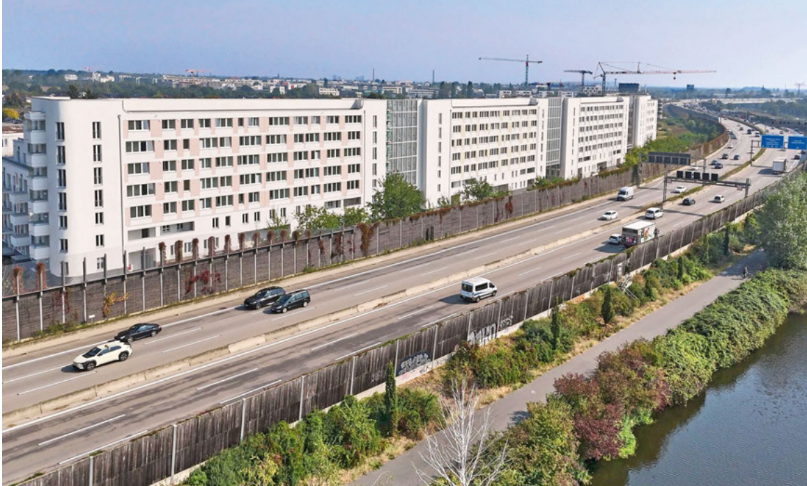
Die volltransparente «Rau Vista» ist Lärmschutzwand und Fassadenelement in einem.
