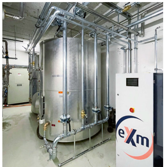
Die eXergiemaschine stellt unabhängig vom aktuellen Verbrauchsverhalten die ideale Temperaturschichtung im Heizspeicher her. (Bild: Grünig&Partner AG)
