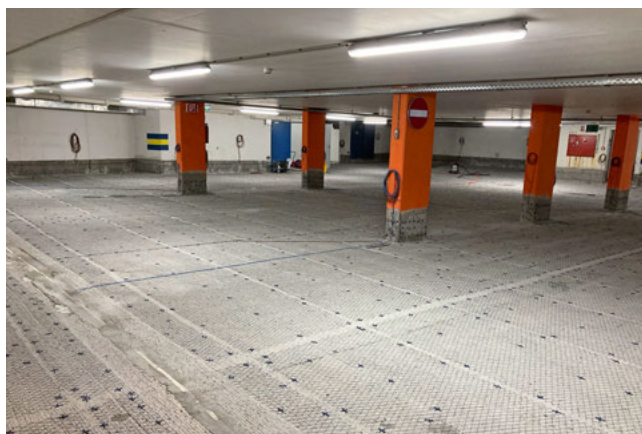
Installierte Anoden auf einer Bodenfläche.
