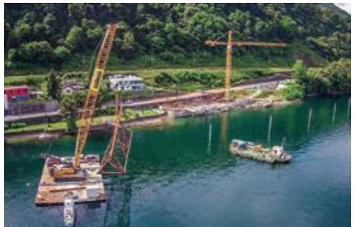
Die Stahlkonstruktion wird langsam im See versenkt.
