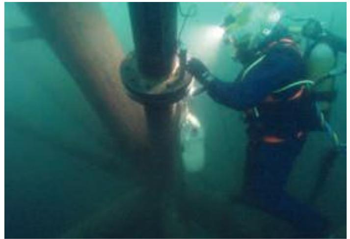
Fuss des Gitterträgers, der unter Wasser verschraubt wird.
