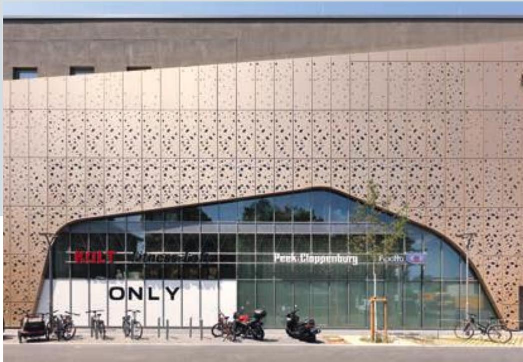
Verglaste Pfosten-Riegel-Konstruktion umgeben von gelochten Aluminiumpaneelen.
