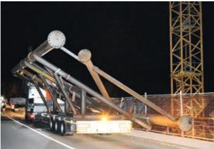
Transport in der Nacht und Positionierung des Gitterträgers auf der auskragenden Arbeitsbühne, bereit für das Versenken.
