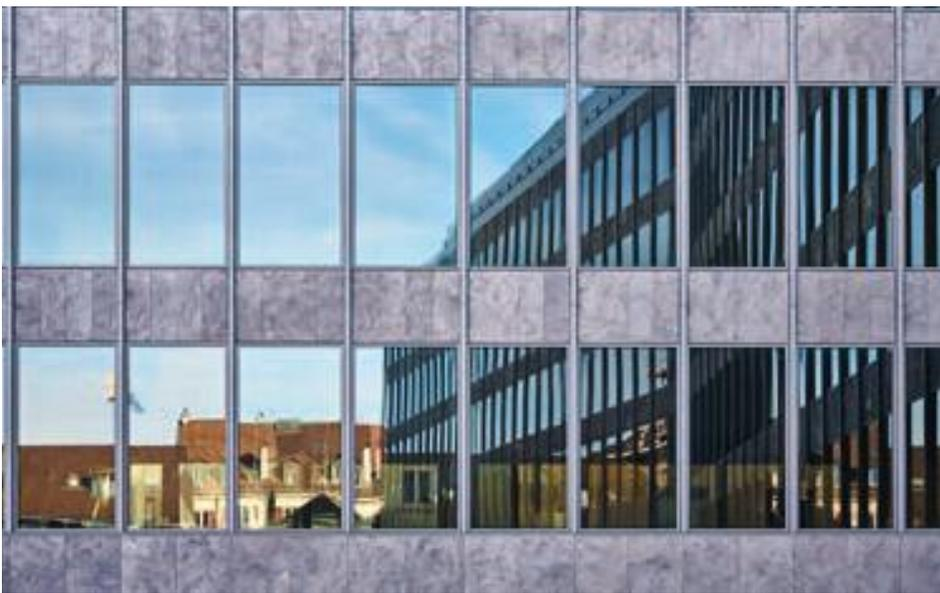
Die Verglasung mit eyrise s350 ermöglicht eine Verdunkelung auf Knopfdruck.
