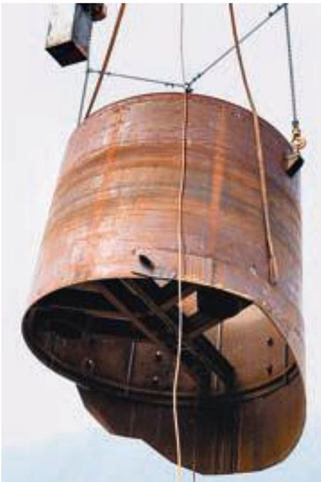
Heben der Metallschalung des Fundaments.
