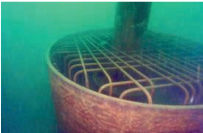
Fundamentalschalung mit Armierungsgitter.
