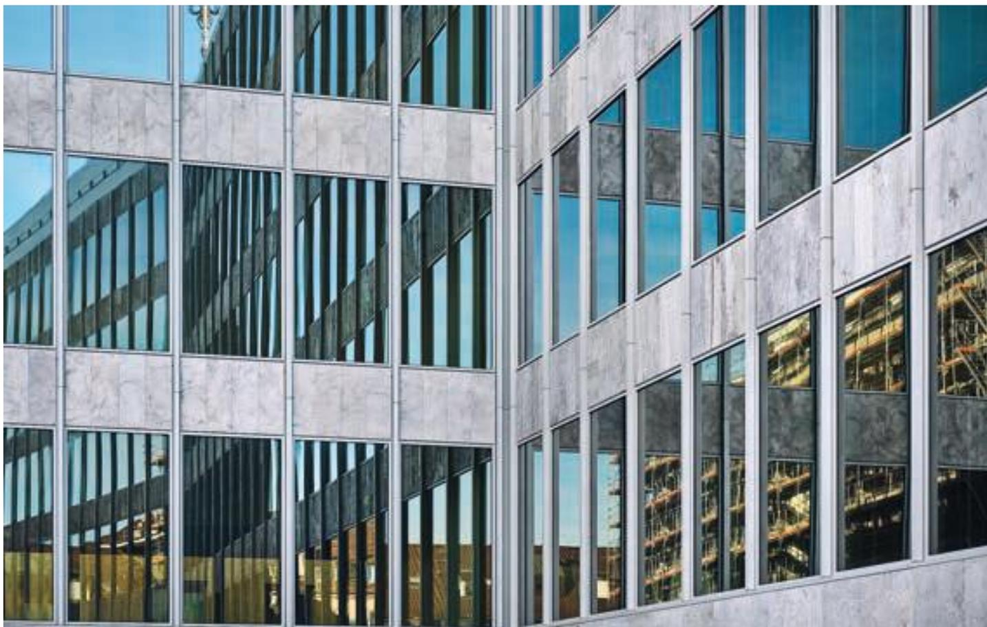
Für die neue Brüstungsverkleidung wurden die bearbeiteten Gussaluminiumplatten der Vorgängerfassade verwendet. Les panneaux en fonte d'aluminium usinés de l'ancienne façade ont été utilisés pour le nouvel habillage des balustrades.
