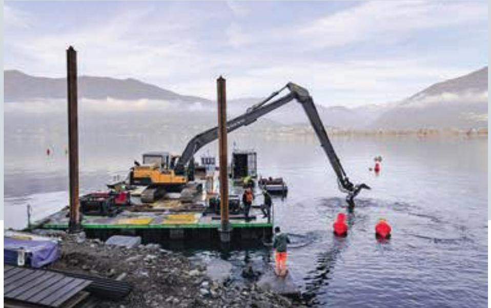
Der Seegrund wird mit dem Bagger vom Schwimmponton aus bereinigt.
