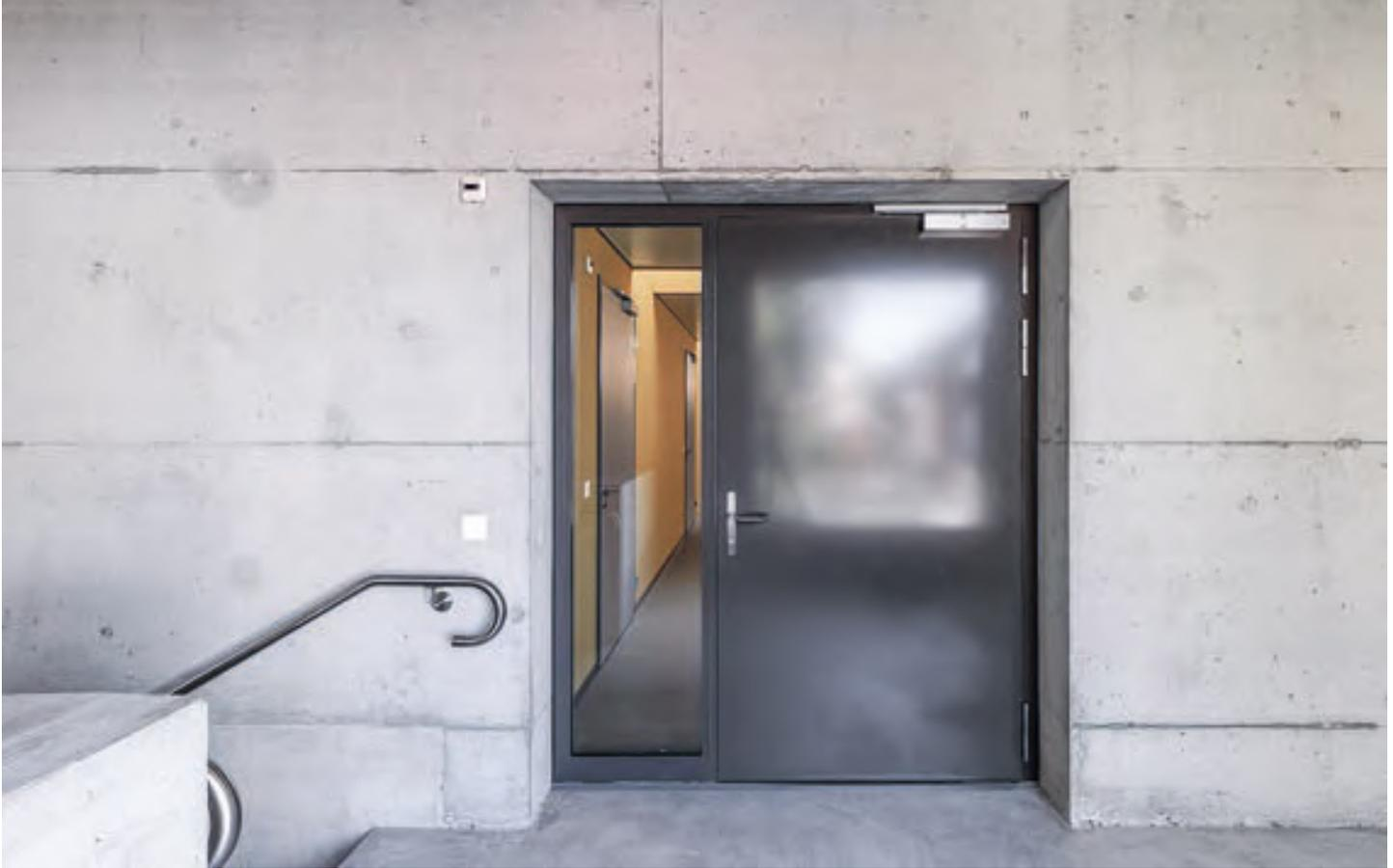
Der Rettungsdienst-Trakt des Spitals Uster ist eines der ersten Objekte, in denen die optimierte Türvariante mit Vollblech-Flügel EI30 eingesetzt wurde. L'aile du poste de secours de l'hôpital d'Uster est l'un des premiers bâtiments à utiliser une version de porte optimisée dotée d'un vantail en tôle pleine de classe EI30.
