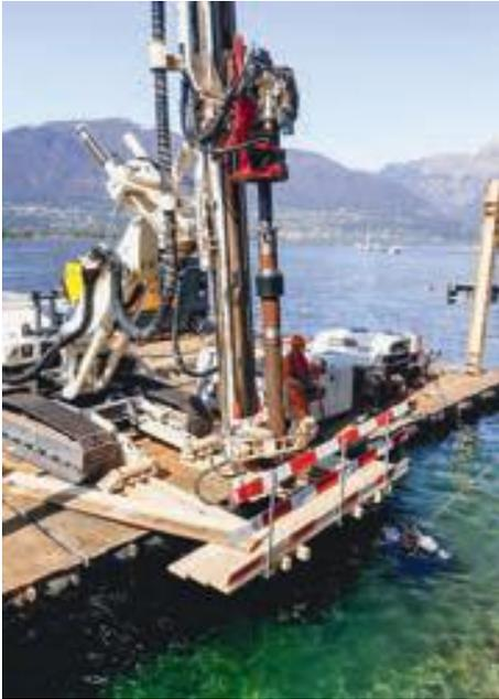
Aushub mit dem Langarmbagger und Bohren der Mikropfähle vom Ponton aus.
