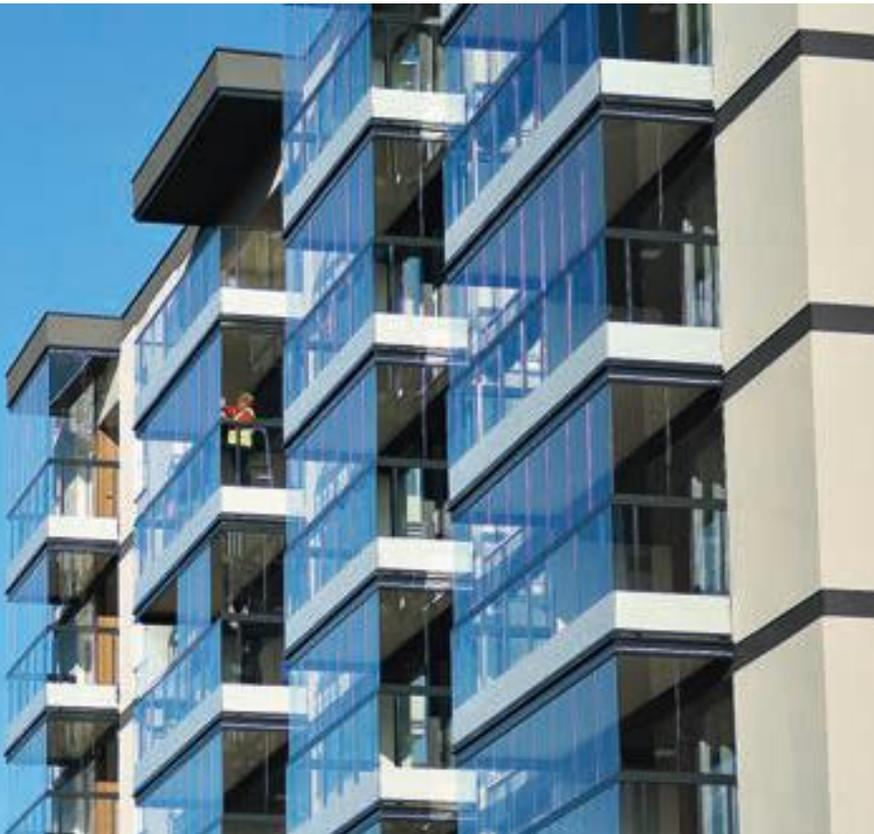
Nicht isolierte Verglasungssysteme bilden Wärmepuffer und schützen vor Wind, Regen und Schall. Les systèmes de vitrage non isolés forment des tampons thermiques et protègent du vent, de la pluie et du bruit.
