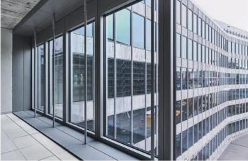
Bei der Einbringung der Fassadenelemente mussten teils erhebliche Bautoleranzen aufgenommen werden.
