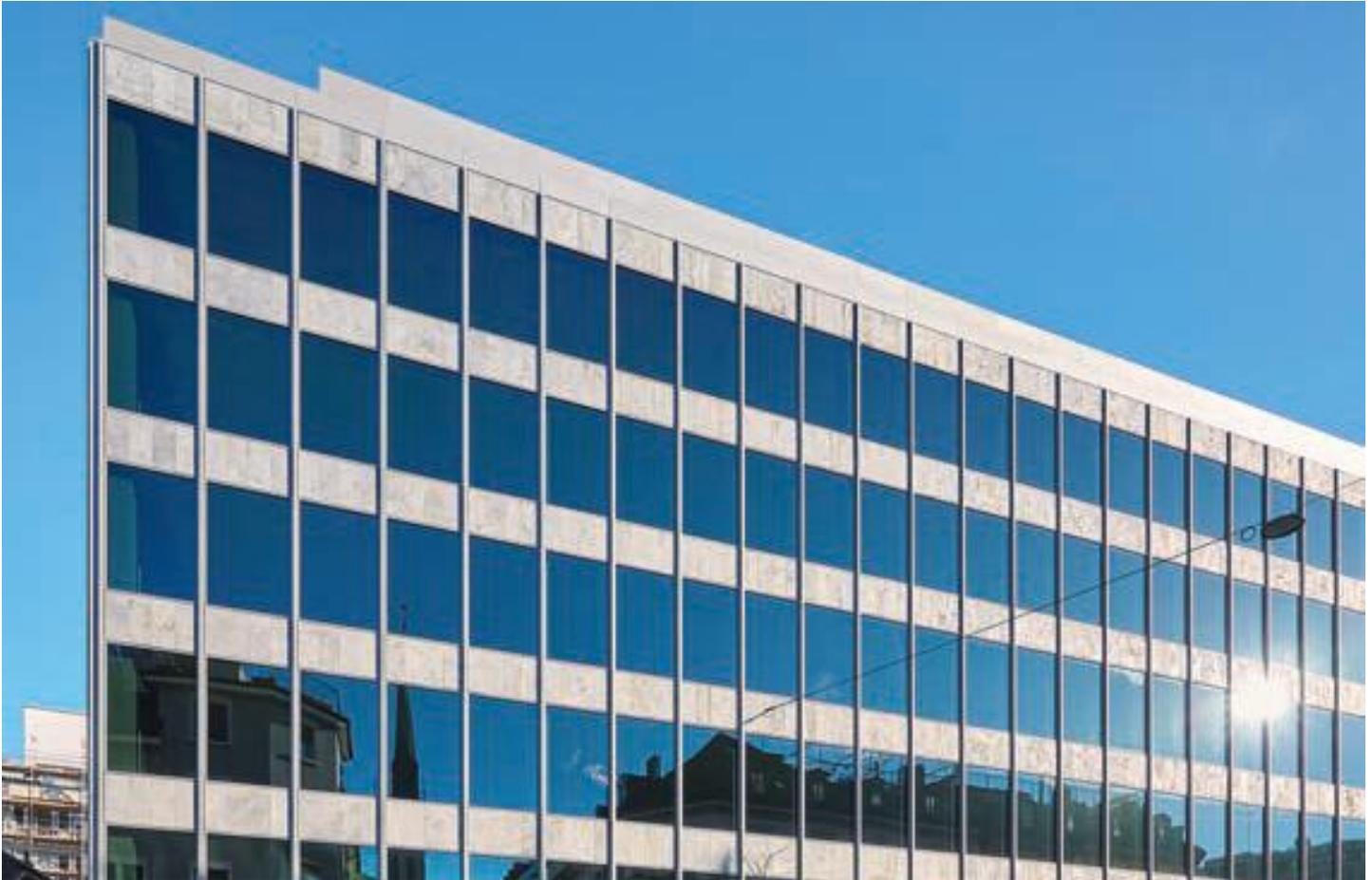
Die neue Elementfassade wurde von Aepli entwickelt, produziert und montiert, inklusive 3000 m<sup>2</sup> dynamisches Sonnenschutzglas.
