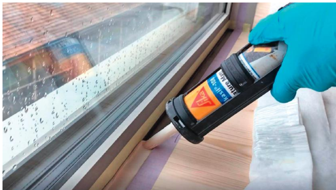
Dauerhafte Versiegelung von Bewegungs- und Anschlussfugen in Innen- und Aussenbereichen mit Sikasil-108 Nature Matt.
