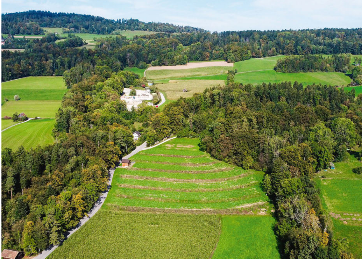
Links: Das Wasserretentionsbecken mit Versickerung am Geuensee (LU) dient als Inspiration für das Projekt «Slow Water». © Johannes Heeb
