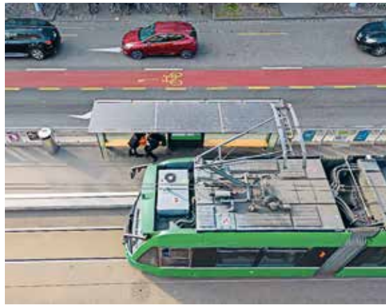
Pilotversuch: An der Haltestelle Markthalle in Basel wurde eine PV-Anlage ins bestehende Glasdach integriert. Essai pilote: à l'arrêt Markthalle à Bâle, une installation PV a été intégrée dans le design du toit en verre.
