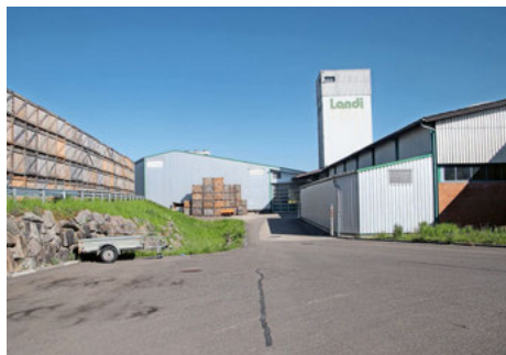
In Marthalen wird ein Ergänzungsbau für eine Agrarhalle mit 768 Palettenplätzen realisiert.
