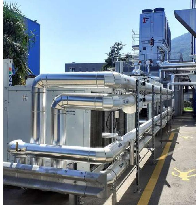
di calore e di un efficiente sistema di gestione degli impianti, si è potuto ridurre di 350'000 kWh il consumo elettrico annuo e eliminare le caldaie, azzerando i costi dell'olio combustibile e le emissioni nocive. Risparmi che permettono il recupero dell'investimento in pochi anni rendendo l'intervento appunto valido anche proprio dal lato economico».
