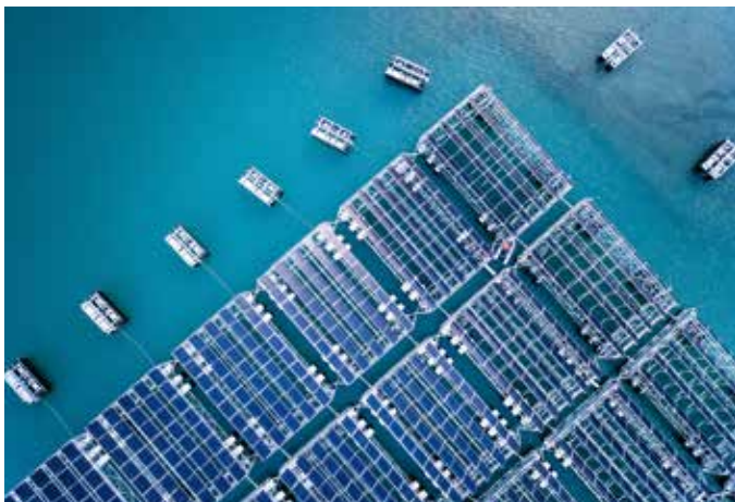
Les 2240 m 2 de panneaux solaires bifaciaux du démonstrateur du parc solaire flottant du lac des Toules. (ROMANDE ÉNERGIE)
