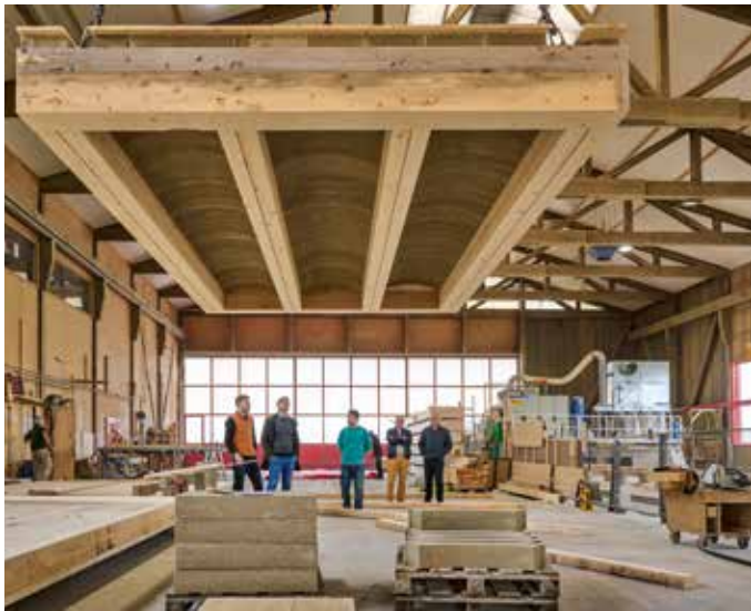
Montage d'un prototype de plancher combinant bois et terre stabilisée Terradek dans la halle de l'entreprise Vial au Mouret (FR). (LEO FABRIZIO)
