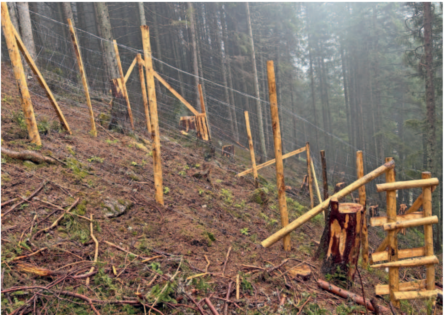
Les jeunes arbres doivent être protégés: ici une clôture de protection contre la faune dans la forêt de Färnig, à Wassen.
