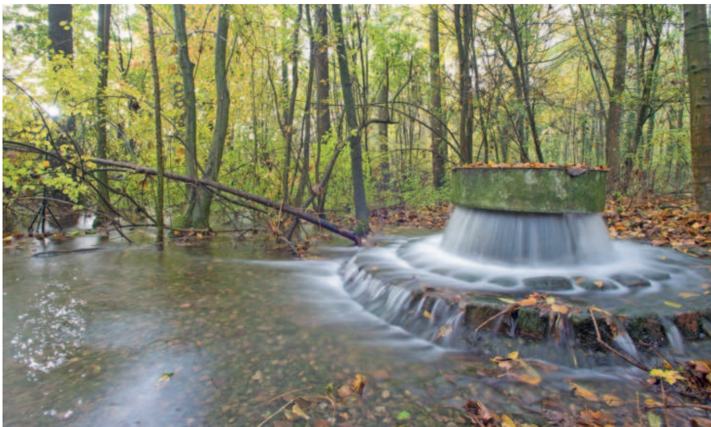
Über den Wasserpilz fliesst das Rheinwasser in die Wasserstellen.
