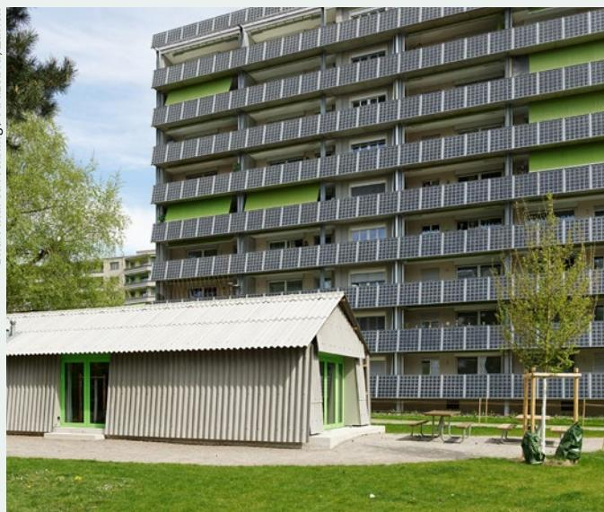
Die SGE installierte bei einer erweiterten Balkonschicht PV-Module und erreicht mit diesen einen hohen Eigenverbrauchsgrad. Im Vordergrund der ebenfalls neue Gemeinschaftspavillon.
