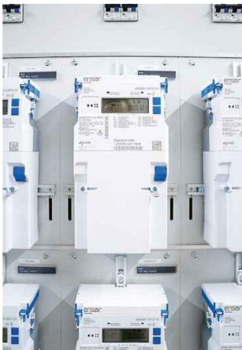
Smart Meter ermöglichen die digitale Übermittlung der Verbrauchsdaten von Strom, Wasser und Gas, ohne dass die Zähler manuell abgelesen werden müssen.
